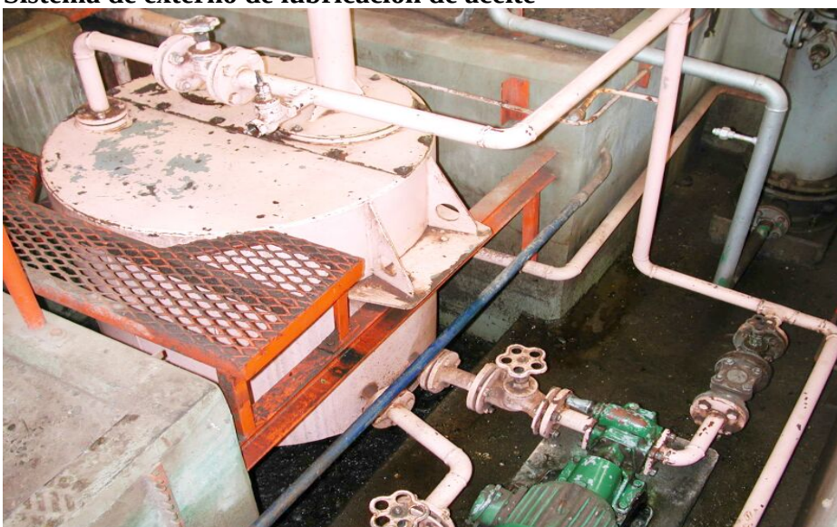
Sistema de externo de lubricación de aceite
