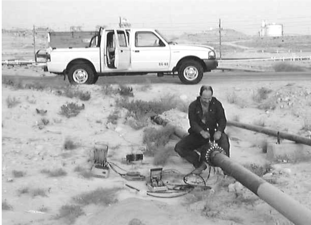
Típica Operación de Teletest. Equipamiento básico.
