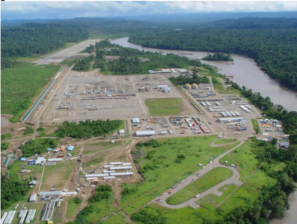
Campamento Base Malvinas. Vista de helipuertos y área de construcción de planta de gas.
