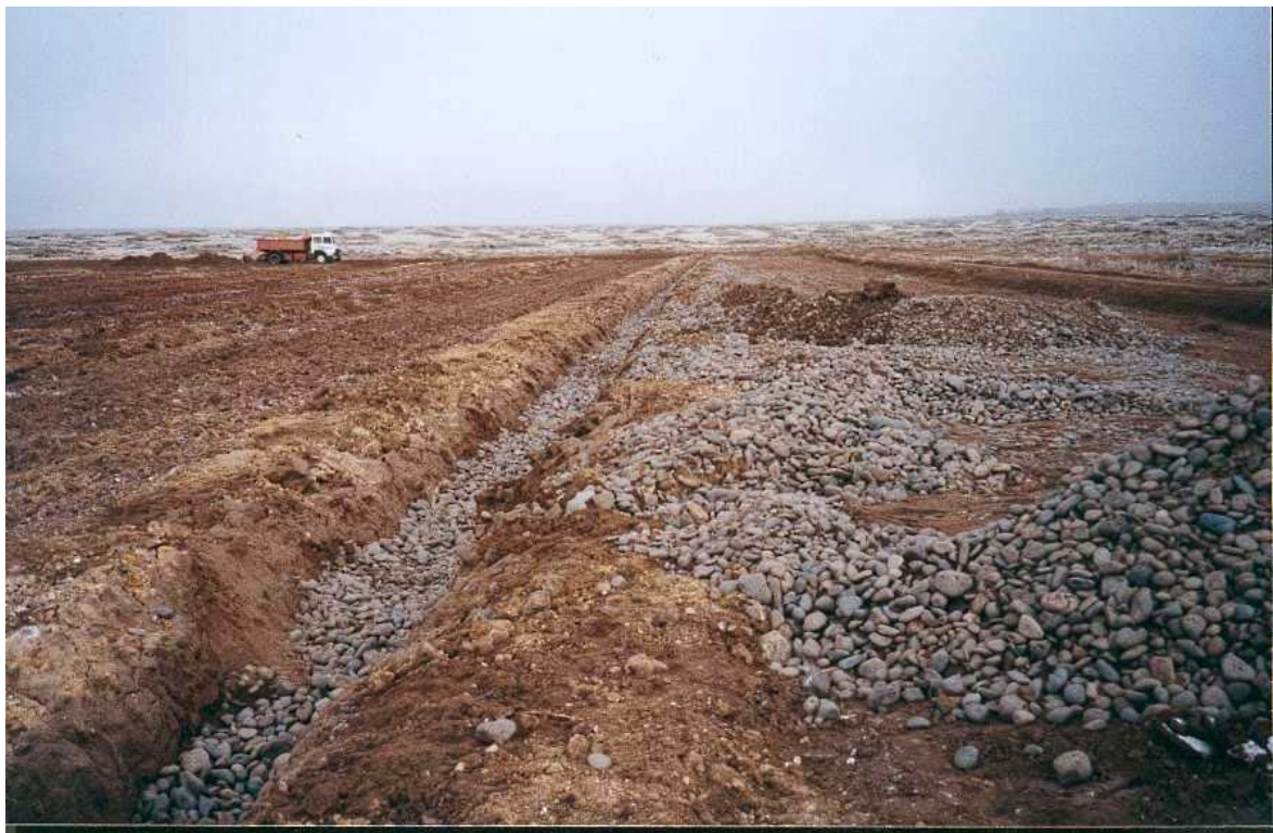
Figura 5. Nivelación del drenaje
