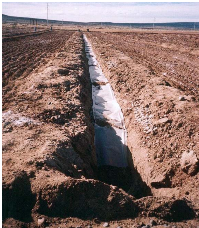
Figura 6. Aplicación de geotextil
