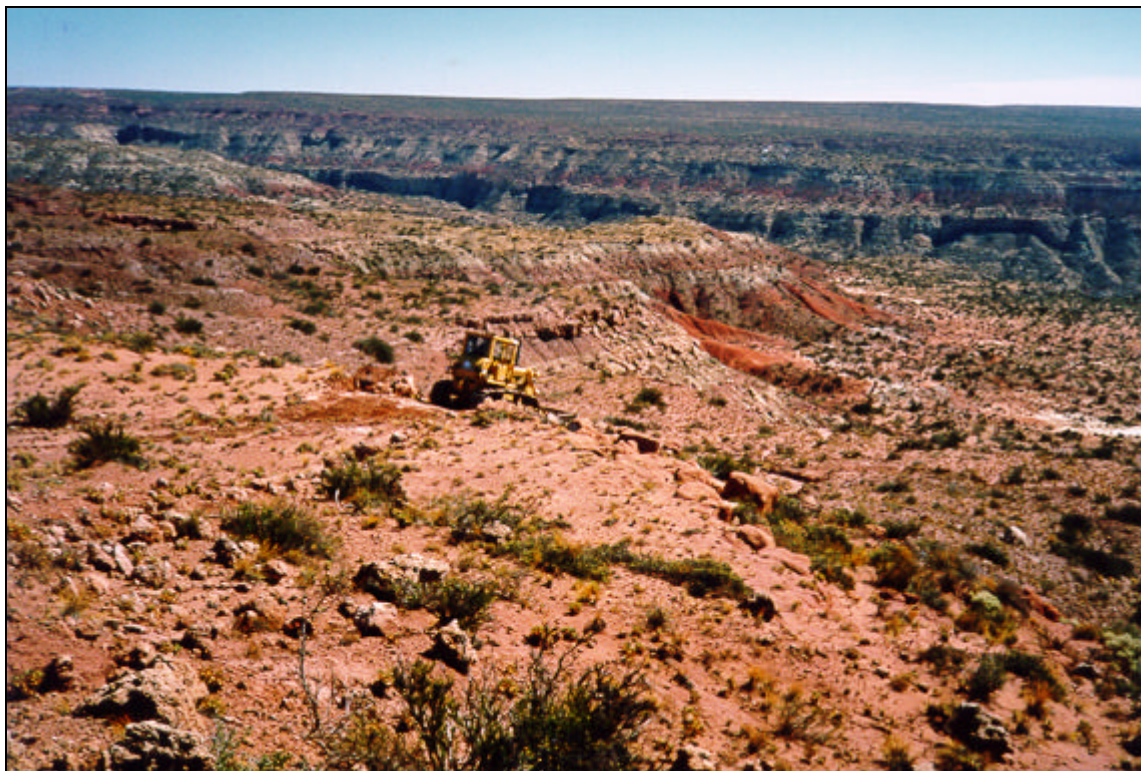
Foto N° 2: Hacia el centro de la fotografía se observa una topadora realizando el repaso de un antiguo acceso. Zona de sensibilidad 1.
