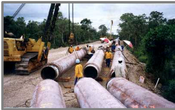
Ilustración 4 Movimiento de Tubos en la Plataforma y Columna Flotante en Zanja Abierta en el Pantanal
