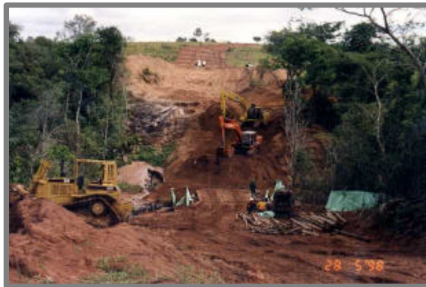
Ilustración 11 – Descenso de la Tubulación (izquierda) y Recomposición Final (derecha) en Riachuelo Encajado en Terreno Susceptible a la Erosión
