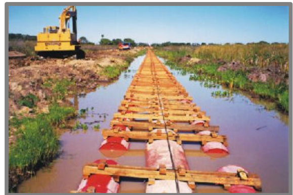
Ilustración 4 Movimiento de Tubos en la Plataforma y Columna Flotante en Zanja Abierta en el Pantanal
