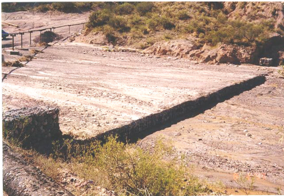
Sección 18 Río de las Piedras Coloradas actualmente
