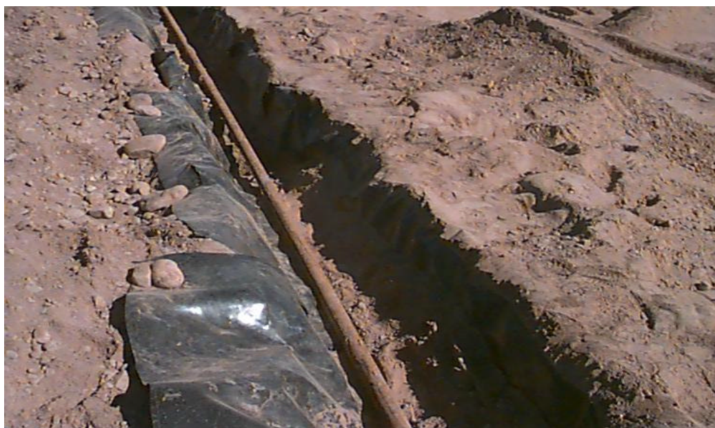
Figura 4. Construcción del sistema de riego.
