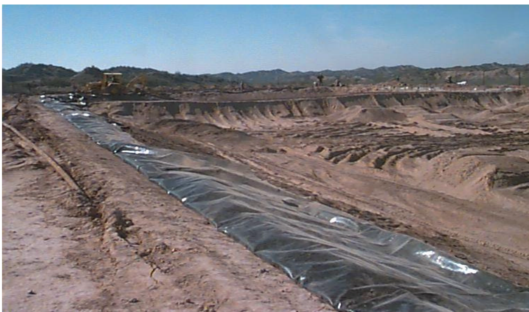
Figura 3. Impermeabilización del sector de tratamiento
