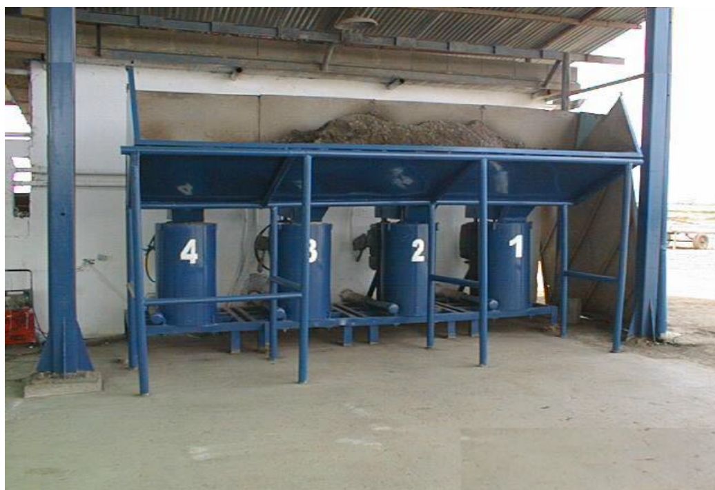
Fig. 7 - MOLIENDA DE LOS RIPIOS DE PERFORACION
