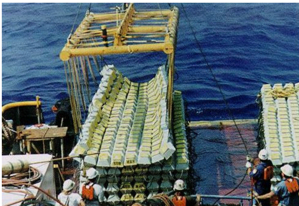
Fig. 13 Losas Flexibles de dados de Hormigón
