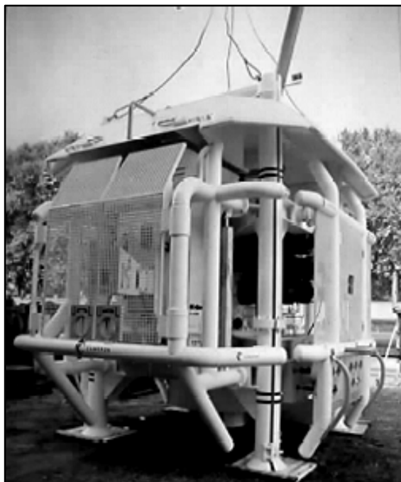
Fig. 5 Árbol de Producción Submarino
