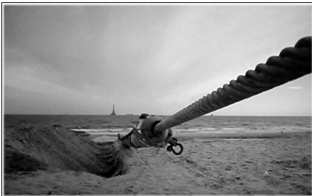
Fig.15 Cabeza de tiro del Umbilical
