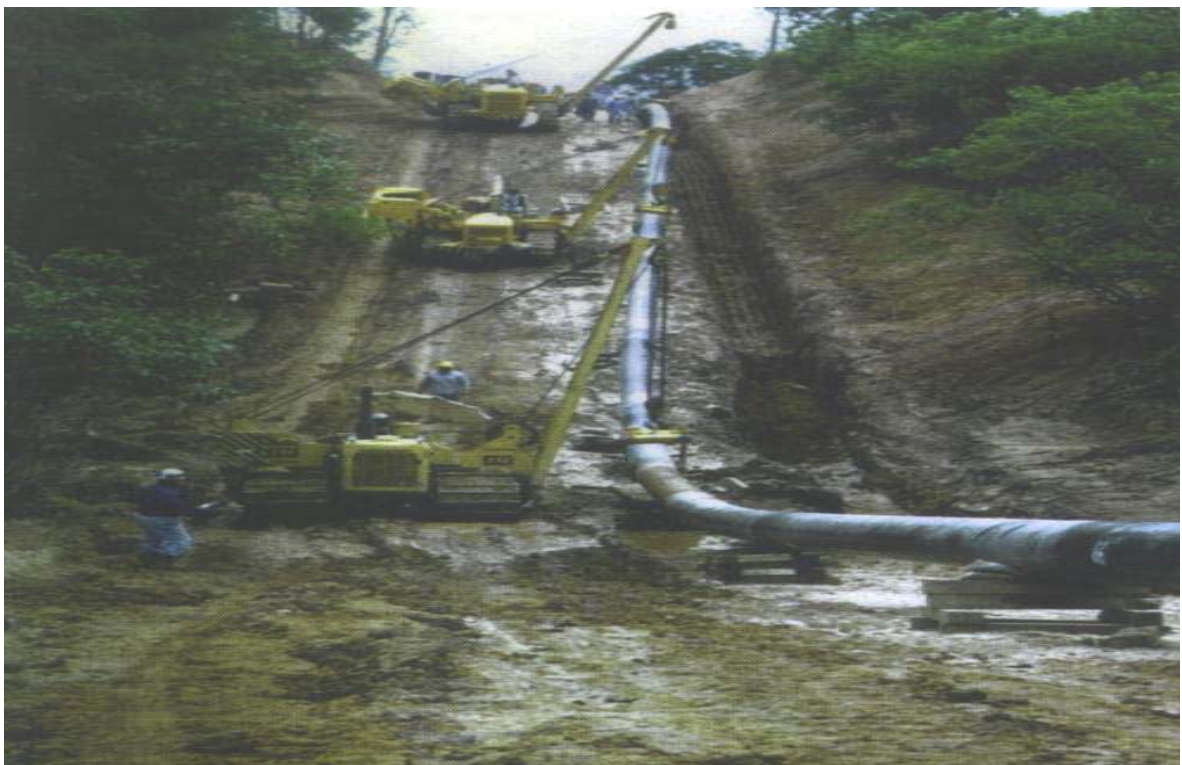
Típica obra de Instalación de Gasoducto donde se combinan los factores enunciados
