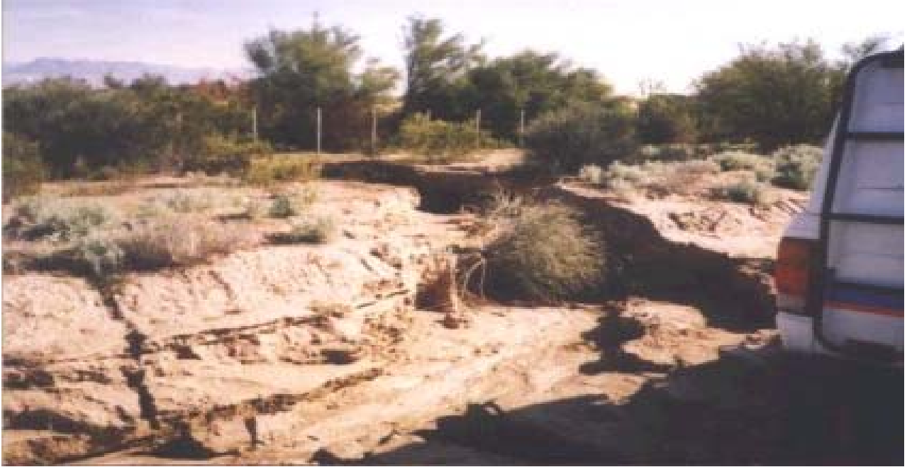
Erosión de suelo – Agua arriba de la Zona anterior
