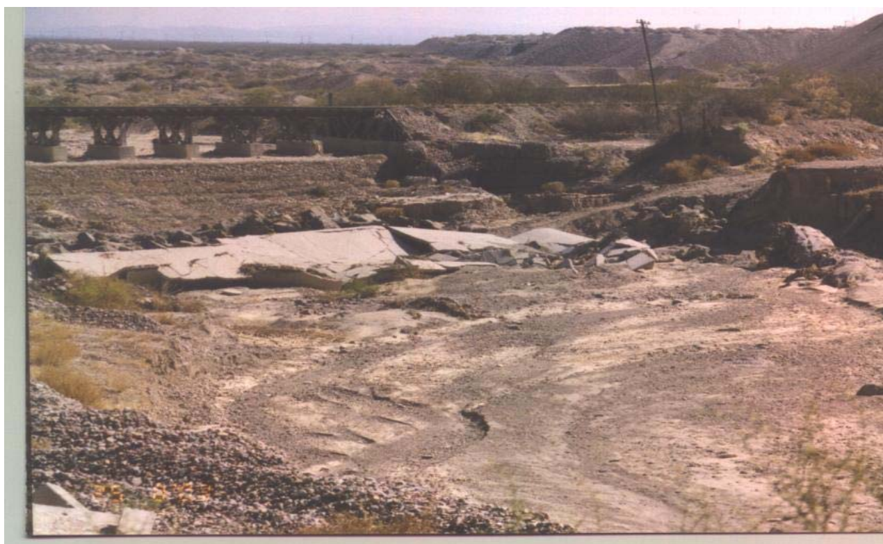
Gasoducto paralelo a vías del FFCC. Zona de extracción de Ripio, Ruta vieja abandonada, Márgenes de arroyo indefinidas por acción del agua.
