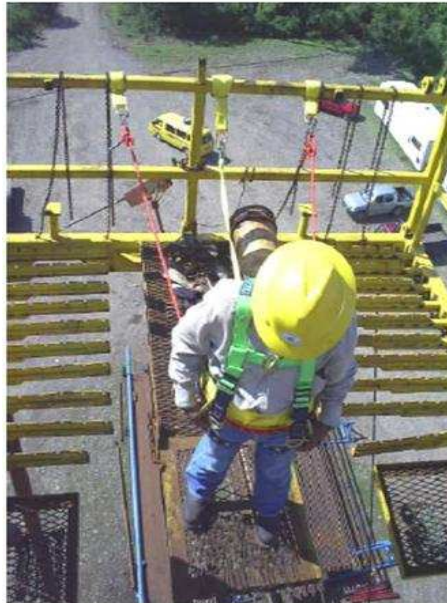
Foto 4. Utilización de equipo para trabajo en alturas
