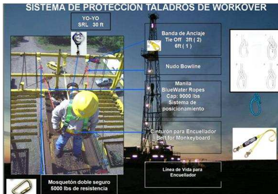
Foto 17. Configuración sistema de protección para el control de caídas
