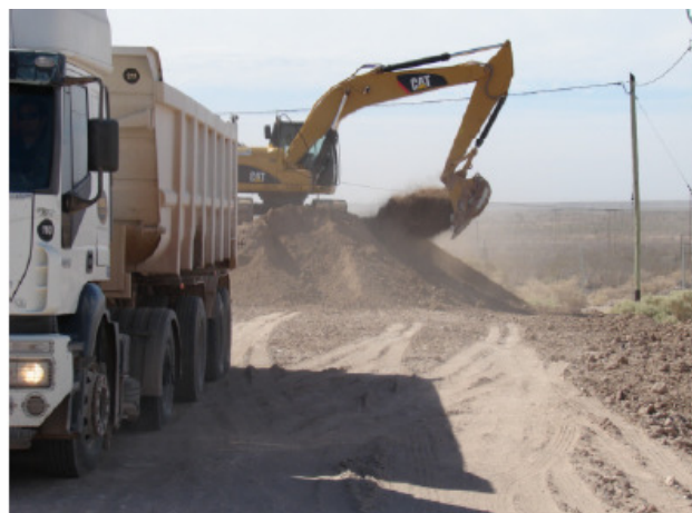
Fig.4 – Mezcla de recortes con material calcáreo
