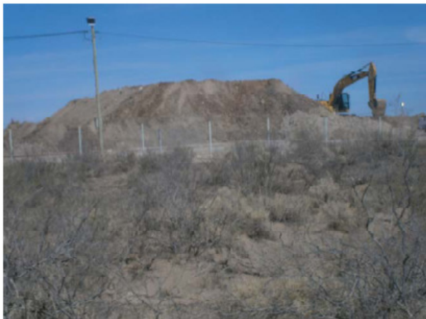
Fig.3 - Remoción de recortes del recinto de acopio
