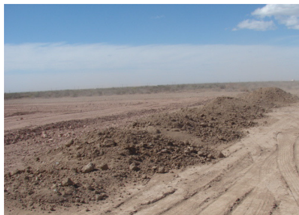
Fig.6 – Colocación de la mezcla en la locación
