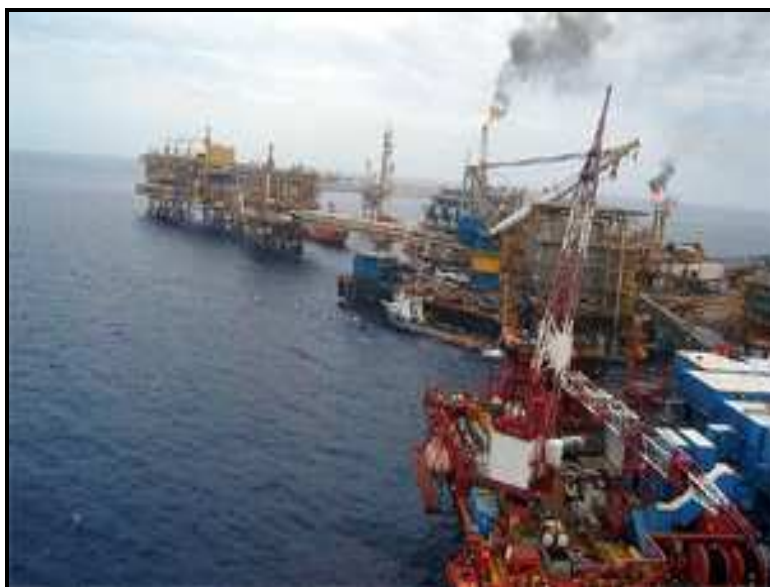
Movimiento de buques alrededor de una plataforma de explotación.
