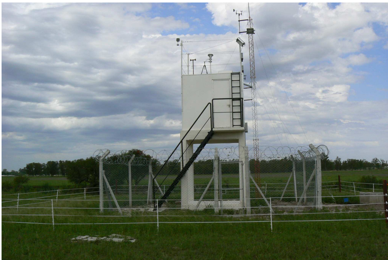
Foto 1: vista de la Estación de Monitoreo Continuo Ubicada en la Central Termoeléctrica Manuel Belgrano
