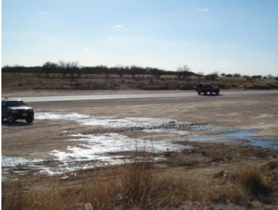
DERRAME POR ACCION DE TERCEROS: Conexión Ilegal.
