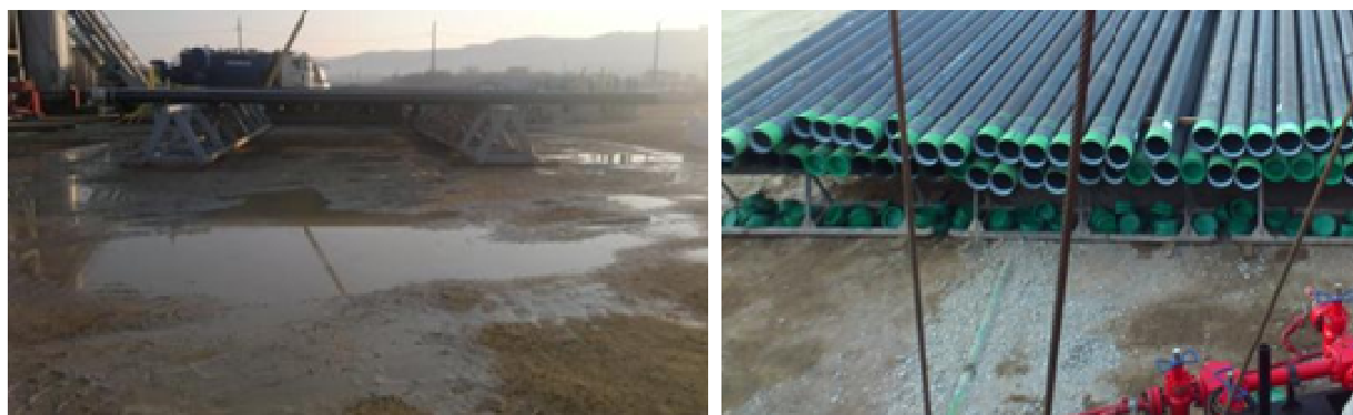
Fig 4: Estado de la locación. (Izq.) Tuberías estándar luego de la remoción de la de grasa de almacenaje usando agua a presión. (Der.) Tuberías con conexiones Dopeless® no requieren limpieza.
