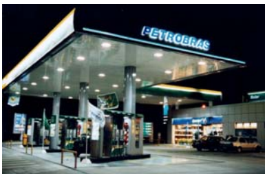
EESS Solar de San Isidro
