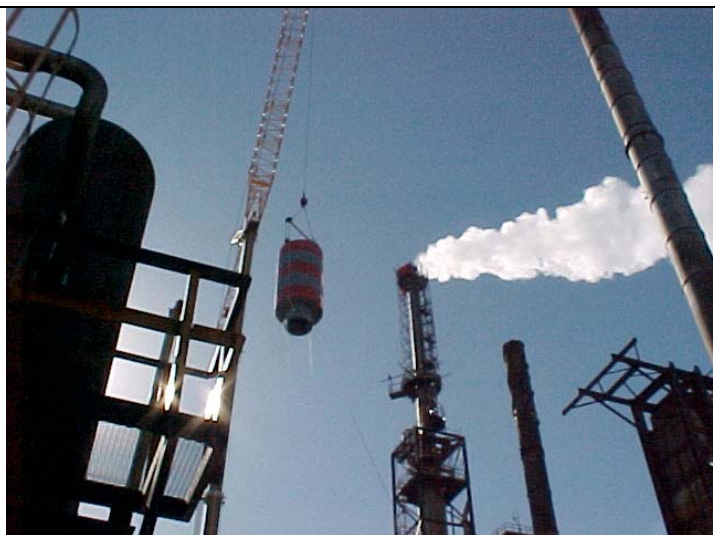
Silenciador temporario a instalar y montaje del mismo
