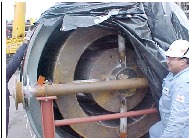
Silenciador temporario a instalar y montaje del mismo
