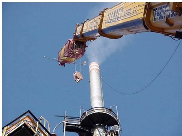
Escaneo sonora de la chimenea de la unidad de craqueo catalítico
