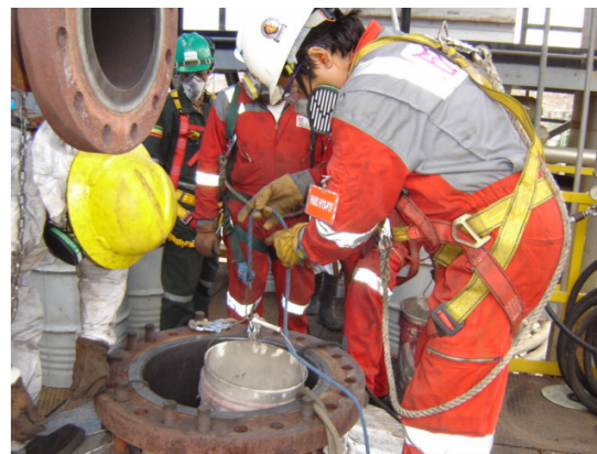
Foto 8 – Ingreso de personal con EPI por la cabeza del reactor Foto 9 – Transferencia de balde con soga al interior del reactor
