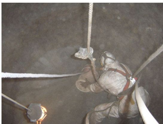
Foto 10 – Personal contratista recogiendo catalizador en atmósfera de Nitrógeno Foto 11 – Personal de refinería vaciando catalizador en tambores
