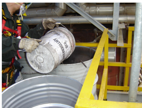
Foto 10 – Personal contratista recogiendo catalizador en atmósfera de Nitrógeno Foto 11 – Personal de refinería vaciando catalizador en tambores
