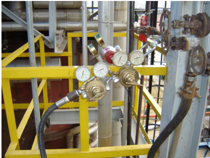
Foto 3 – Manómetros reductores de presión en la línea de Nitrógeno
