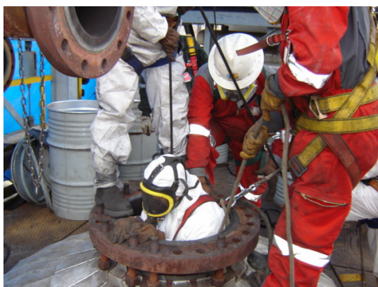
Foto 8 – Ingreso de personal con EPI por la cabeza del reactor Foto 9 – Transferencia de balde con soga al interior del reactor
