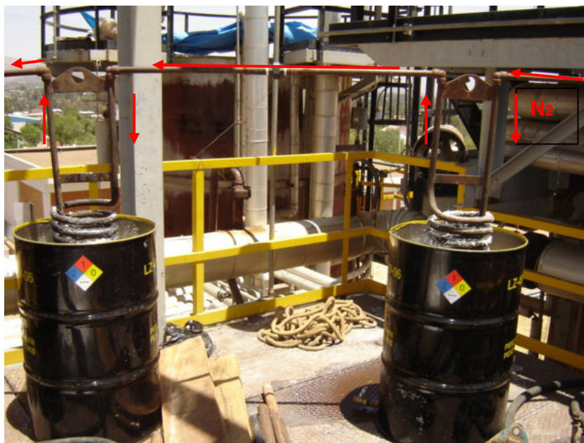
Foto 2 – Sistema de enfriamiento adicional de Nitrógeno
