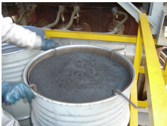
Foto 12 – Personal contratista tamizando catalizador en plataforma Foto 13 – Vista de material cerámico extraído del fondo del reactor
