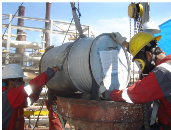
Foto 14 – Colocación de embudo y manga para vaciado de catalizador Foto 15 – Vaciado de catalizador desde los tambores
