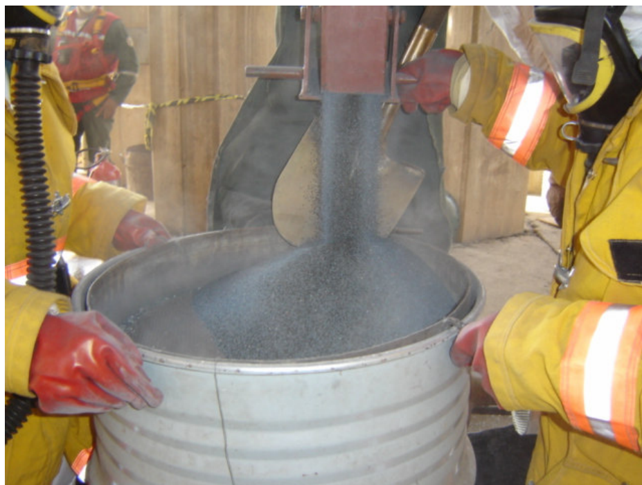
Foto 7 – Descarguío del catalizador por la manga
