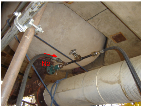
Foto 6, a - Conexión inferior de Nitrógeno al reactor; b - Conexión de Nitrógeno a la manga
