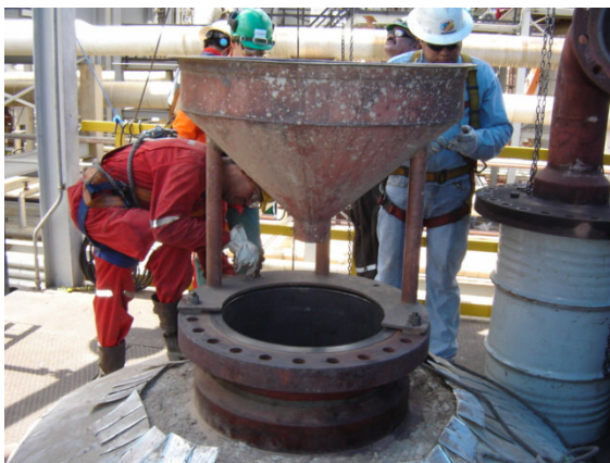
Foto 14 – Colocación de embudo y manga para vaciado de catalizador Foto 15 – Vaciado de catalizador desde los tambores
