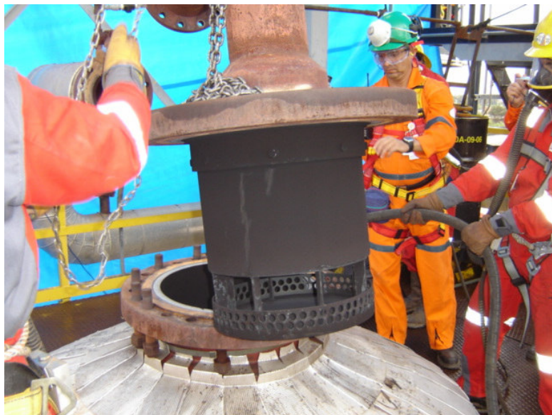
Foto 5 – Extracción de distribuidor de la cabeza del reactor
