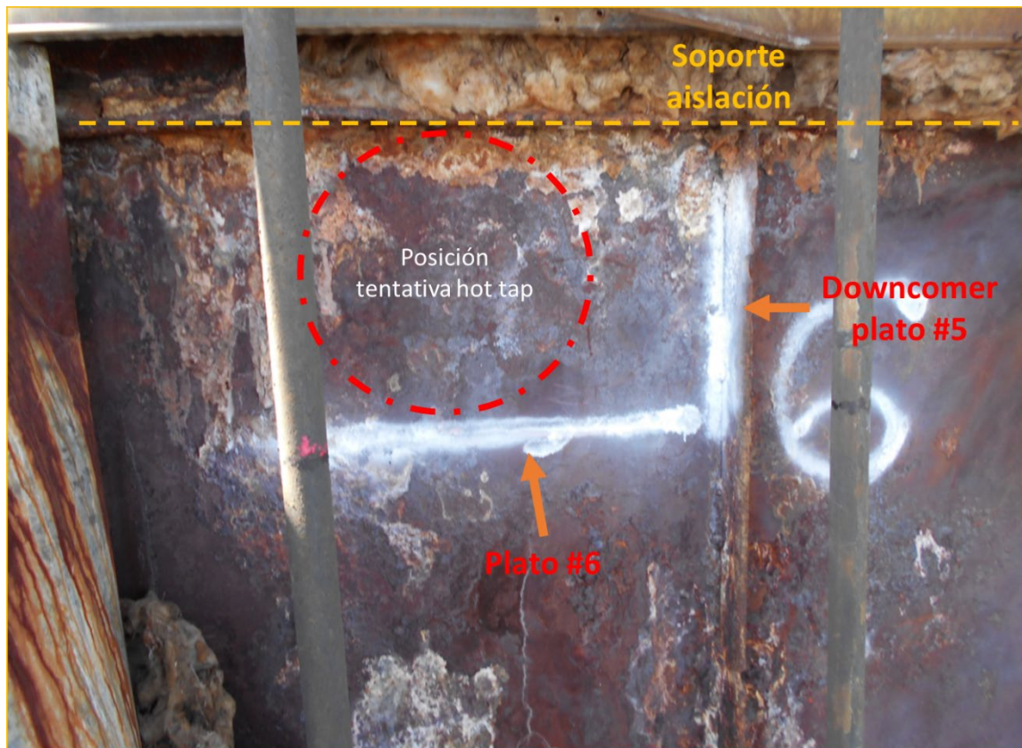
Figura 8: Identificación de la posición en donde realizar hot tap
