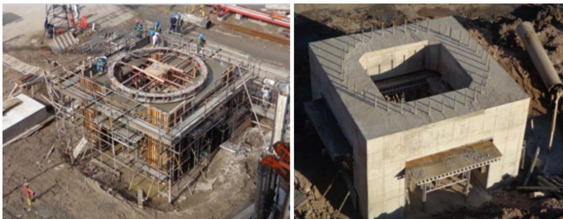
Figura 8 – Base de hormigón de la columna con sus pernos de anclaje.
