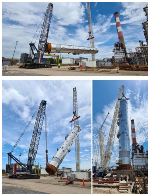
Figura 10 – fotos del izaje de la columna.
