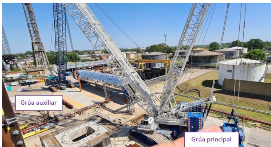
Figura 9 – Grúa principal y auxiliar para izaje de nueva columna.
