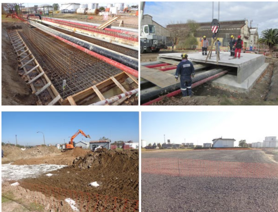
Figura 7 – Adecuación de terreno dentro de la Refinería.
