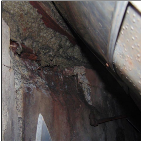
Imagen 8: Pared interior de losa de soporte
