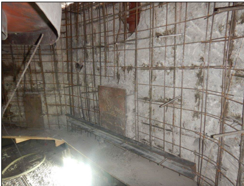
Imagen 19: Fotografía desde interior de refuerzo de armaduras y malla
