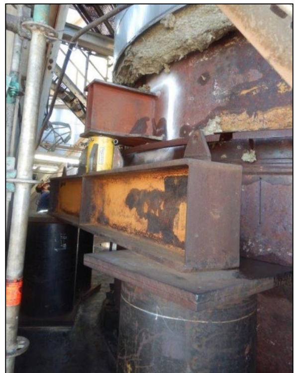
Imagen 15: Fotografías de sistema de elevación y ménsulas de soporte en la estructura
