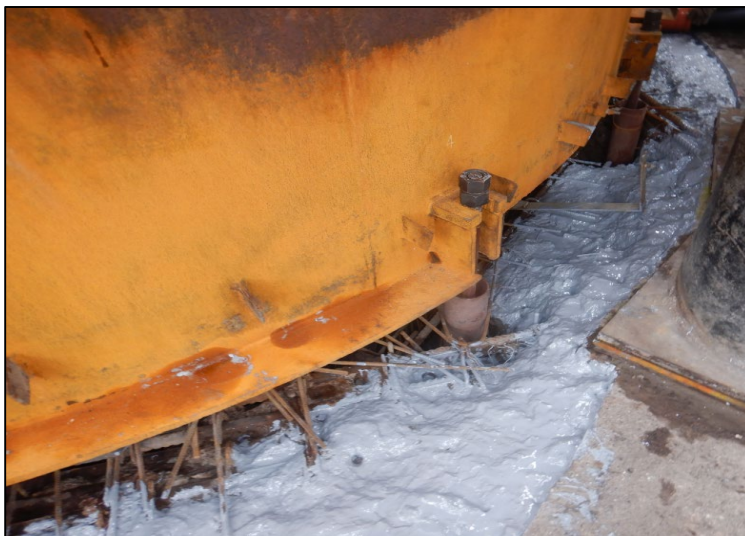
Imagen 22: Fotografía de colocación de puente de adherencia
