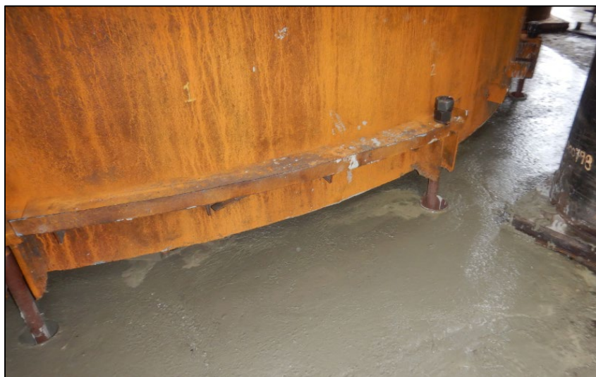
Imagen 24: Fotografía de hormigonado terminado
