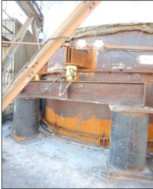
Imagen 14: Fotografía de sistema de elevación
