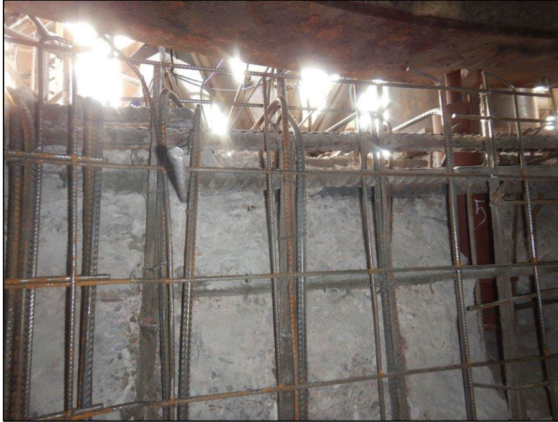
Imagen 20: Fotografía desde interior de refuerzo de armaduras y malla
