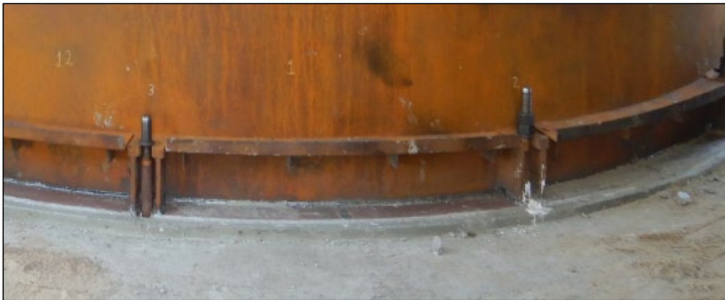
Imagen 25: Fotografía de grouting y sellado finalizado
