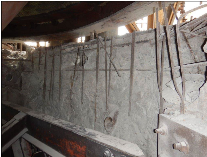
Imagen 17: Demolición de hormigón en malas condiciones
