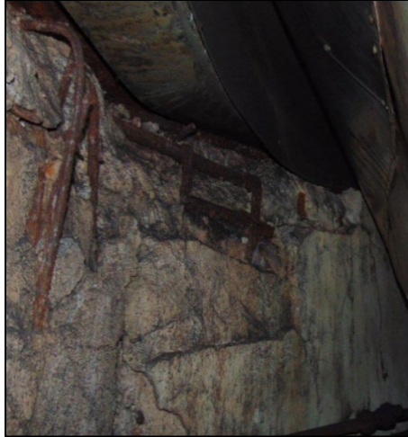
Imagen 7: Pared interior de losa de soporte
