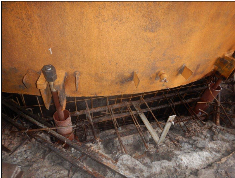
Imagen 21: Fotografía desde exterior de refuerzo de armaduras y malla
