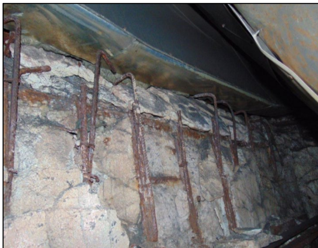
Imagen 9: Pared interior de la losa de soporte
