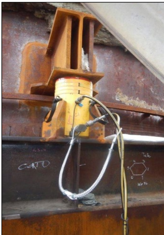
Imagen 15: Fotografías de sistema de elevación y ménsulas de soporte en la estructura
