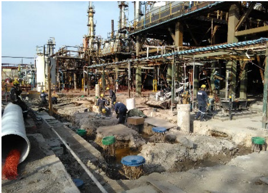
Ilustración 13 - Pilotaje de la PFU.
