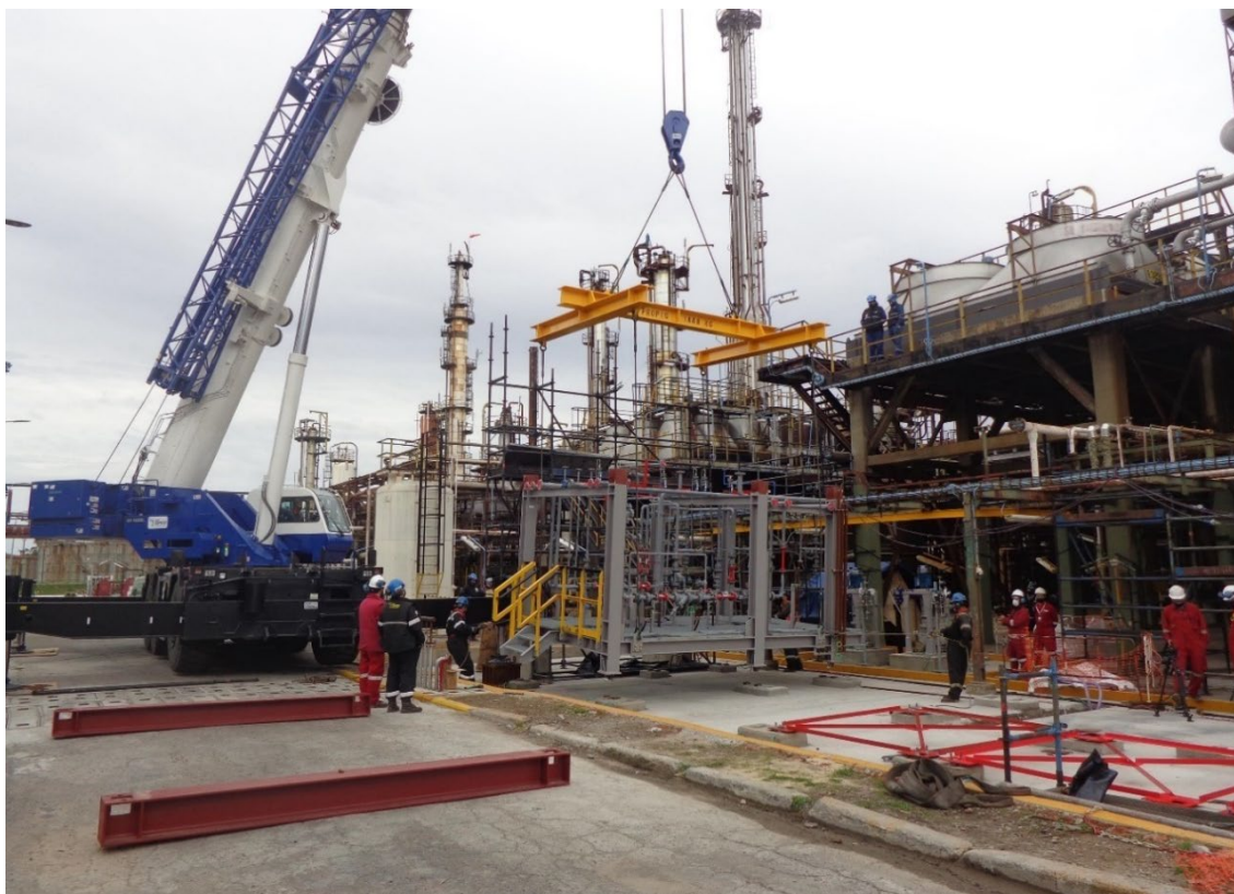
Ilustración 15 - Montaje del primer módulo de la PFU.
