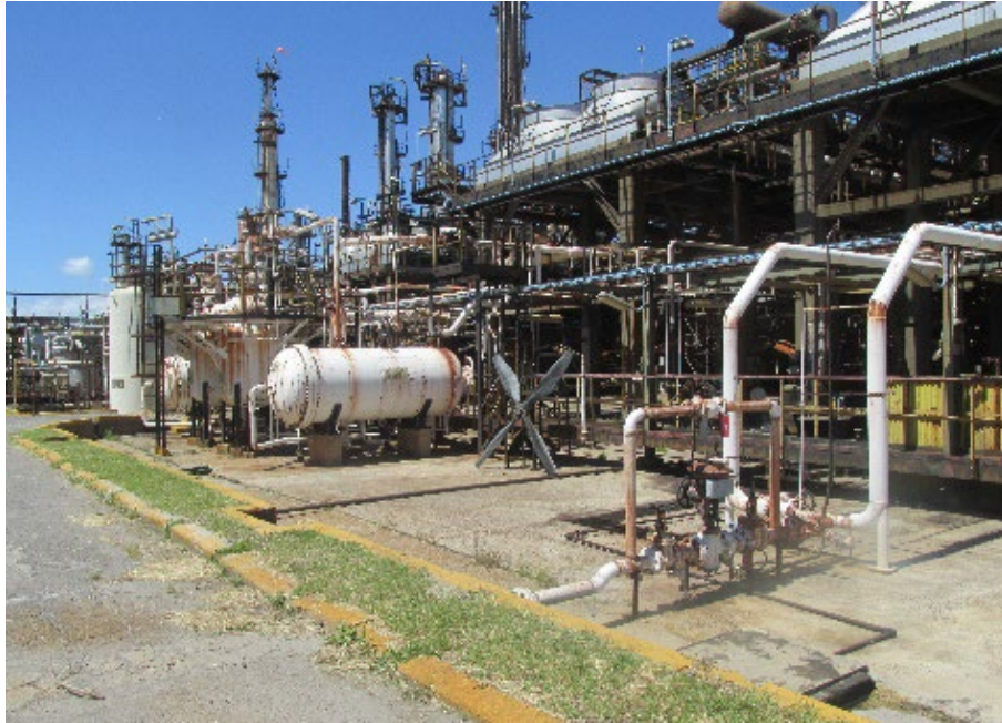
Ilustración 12 - Desmontaje de antigua U-800.
