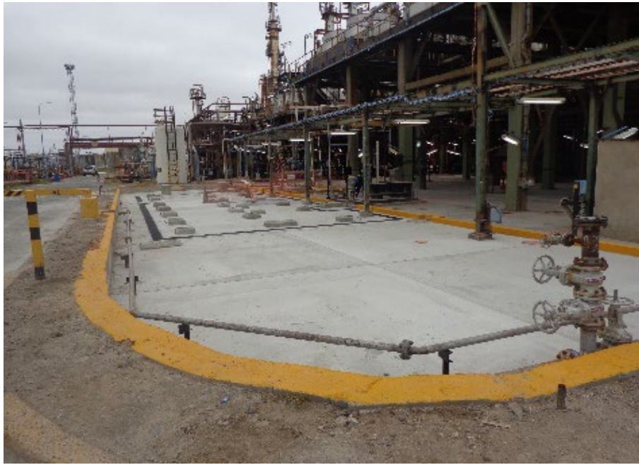
Ilustración 14 - Construcción de nueva platea para la PFU.
