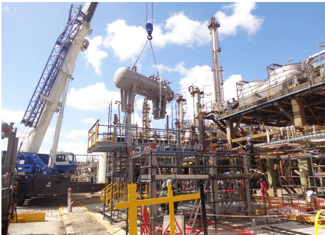
Ilustración 16 - Montaje del recipiente acumulador de la PFU.
