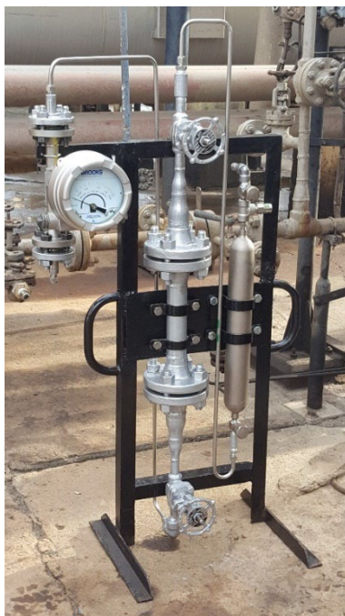
Ilustración 2 - Instalación de prueba batch .
