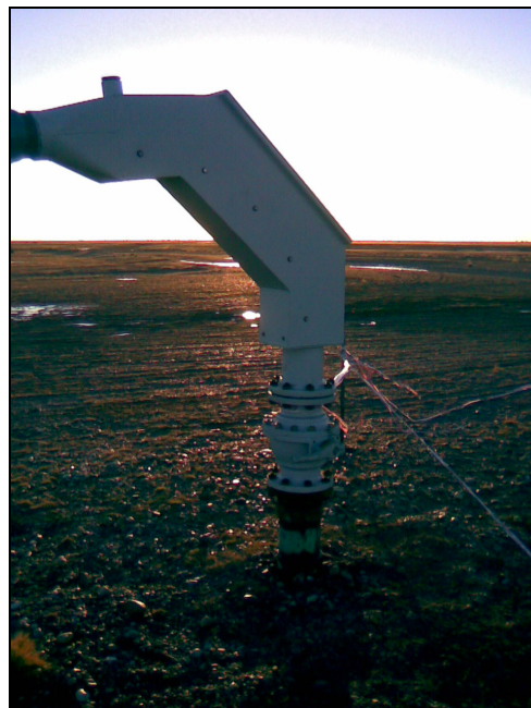
Figura 21. Boca de pozo
