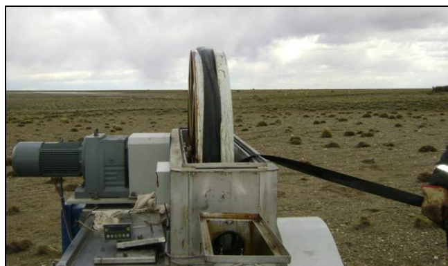
Figura 30 Cinta transportadora mal enrollada
