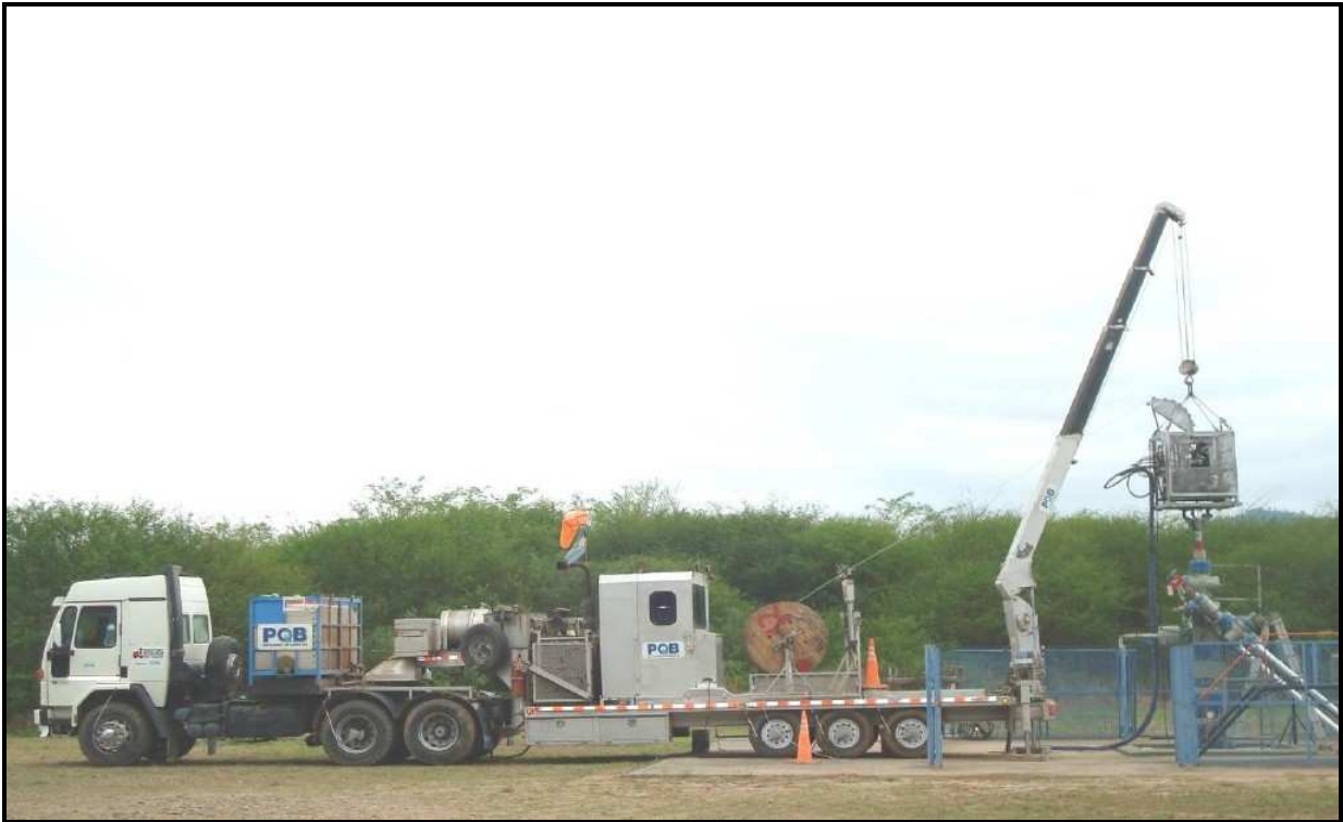
Foto 1: Rig de Capilares en Operación en el Pozo Po.x-1001
