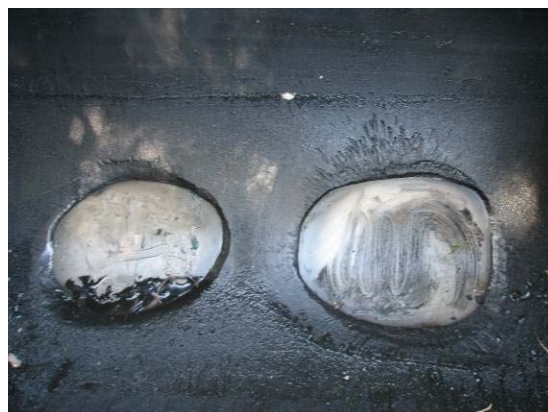
Figura 2: Parches en línea de transferencia
