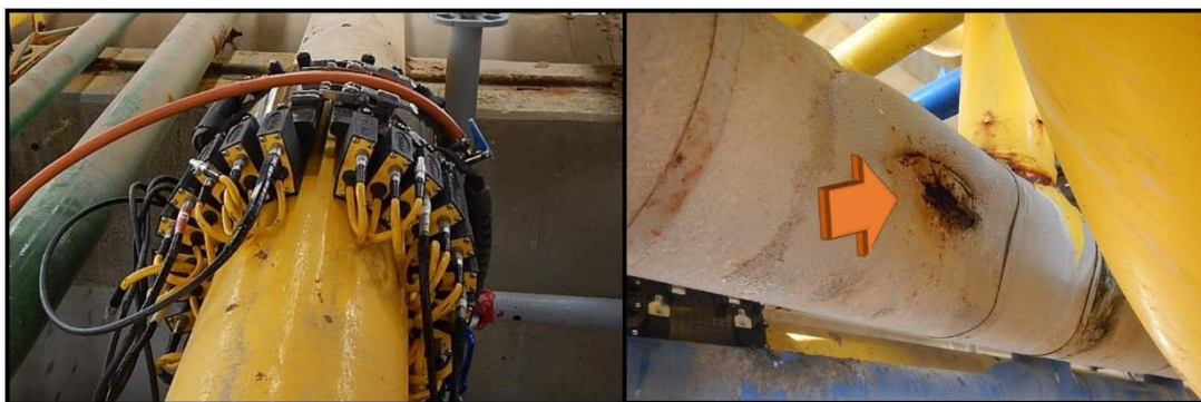
Figura 5. Ensayo de ondas guiadas en tubería.
