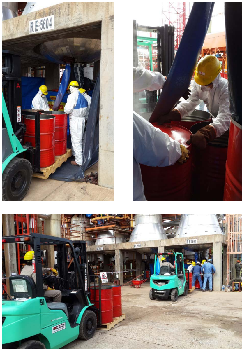
Fig. N°1: Descarga del catalizador R-62.
