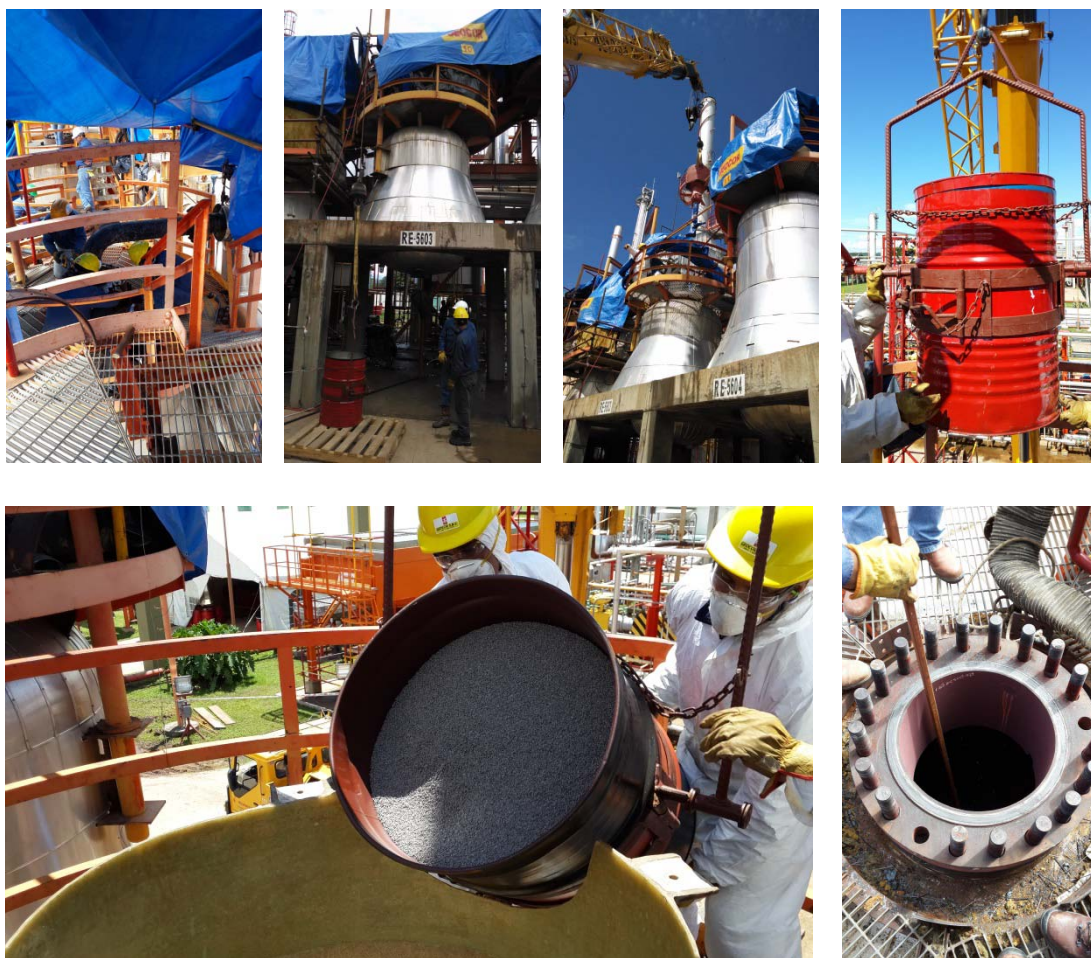
Fig. N°3: Carga del catalizador R-500
