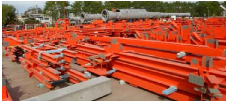
Acopio de perfiles en helipuerto – figura 2
