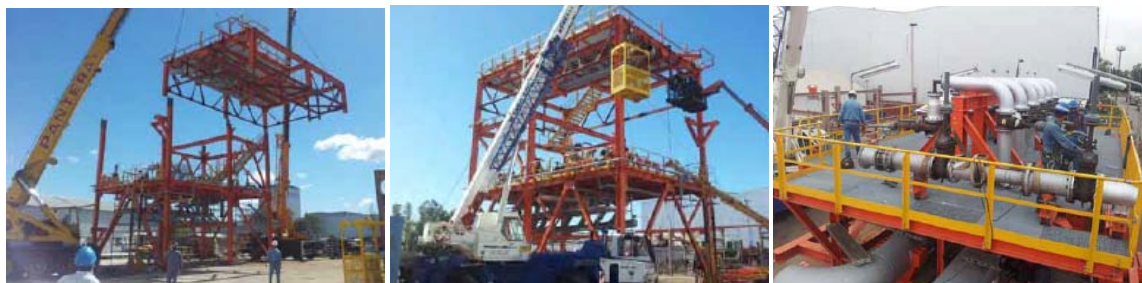
Módulos de procesos prearmados en Canning – figura 20
