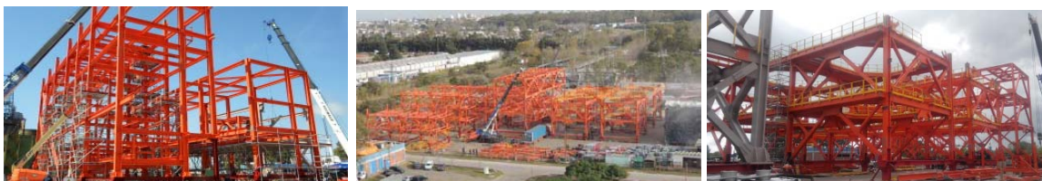
Prearmado de módulos en helipuerto – figura 3
