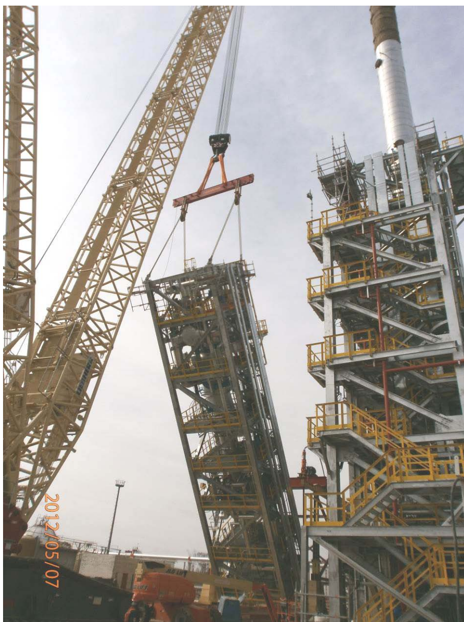
Fig. 4. Módulo de la unidad CCR siendo izado para su montaje – Gentileza Odebrecht
