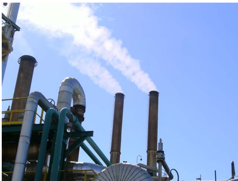
Figura 18 – Horno F104B Refinería La Teja, aspecto de las chimeneas durante la limpieza química
