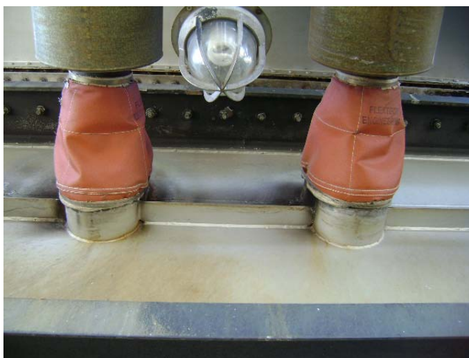
Figura 3 – Horno F-1 Refinería Campana; colocación de Sellos Flexibles
