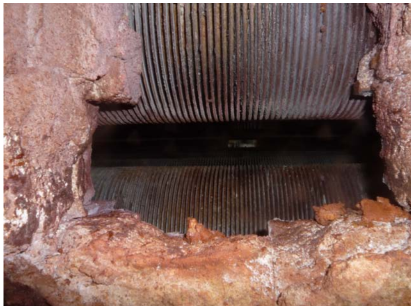
Figura 9 – Horno F-101 Refinería Campana, estado final de limpieza de los tubos aletados de la zona convectiva
