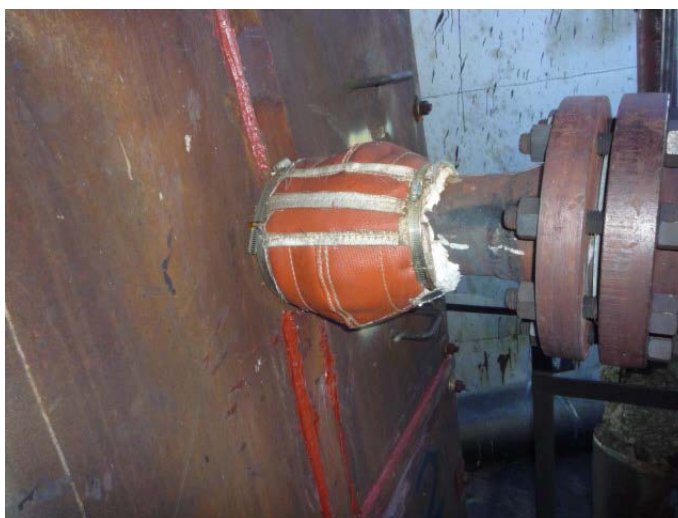
Figura 5 – Horno F-601 Refinería Campana, colocación de sellos flexibles y sellado de juntas con silicona de alta temperatura
