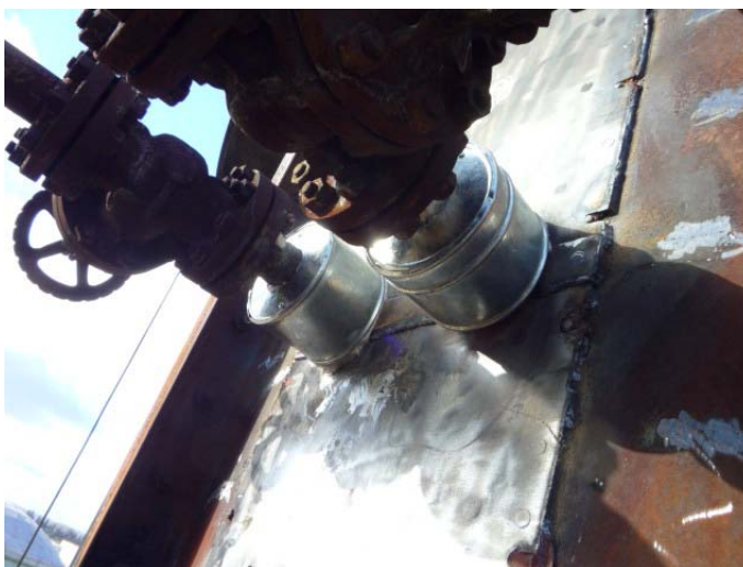
Figura 4- Horno F-101 Refinería Campana; colocación de sellos pasatubos hechos con chapa de aislación y colocación de parches soldados externos
