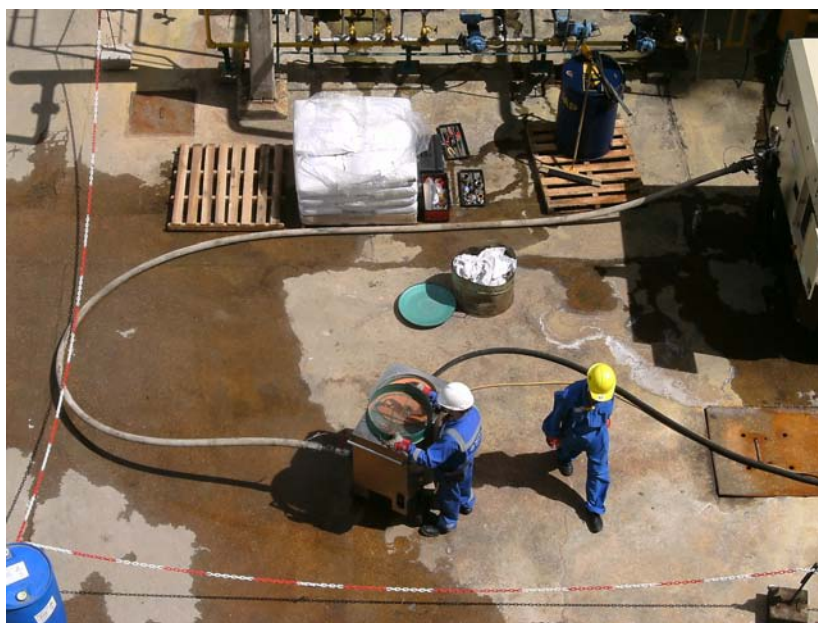
Figura 14 – Horno F-140B Refinería La Teja, disposición del equipamiento durante la limpieza química
