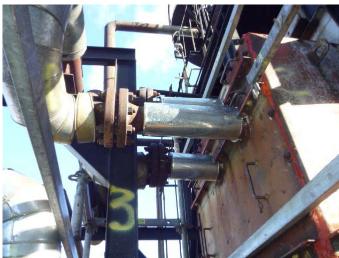
Figura 6 – Horno F-601 Refinería Campana, sellado de juntas con silicona de alta temperatura y colocación de sellos pasa tubos hechos con chapa de aislación
