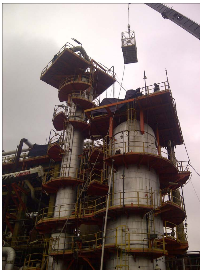
Figura 3: Intervención de C-1101 y C-1102. Operaciones de izado y trabajo en altura.
