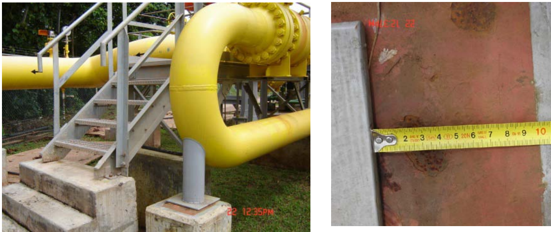
Figura 6 Desplazamientos en Trampa de Scraper de Ø20"
