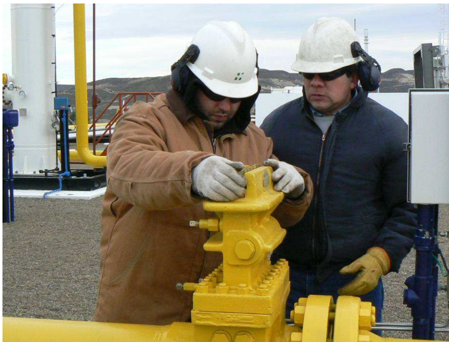
Fotos 6. Cambio de placa orificio en medidor de caudal de Salida de Planta
