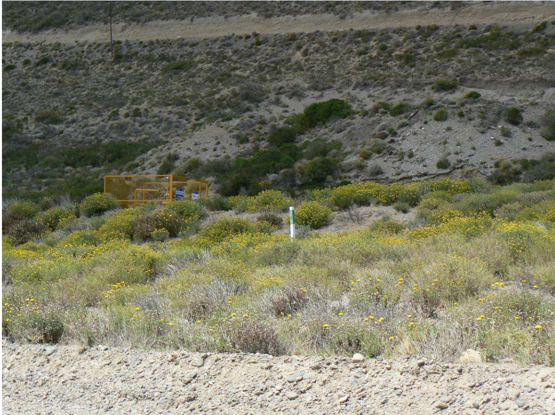
Foto 5. Talud de locación de pozo inyector de gas, con revegetación nativa sin riego, como consecuencia de preservar el suelo natural con banco de semillas.
