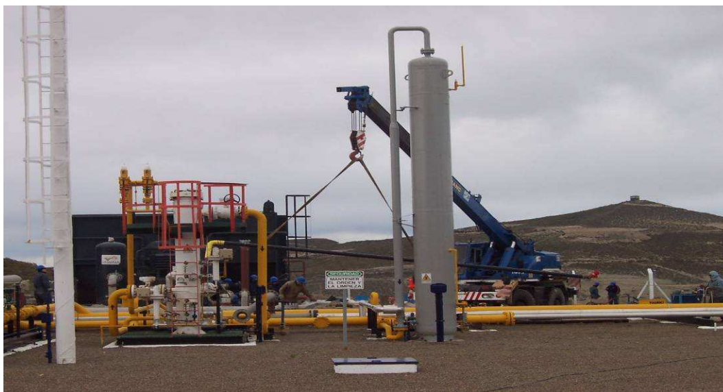
Foto 7. Aspectos de trabajos de ampliación en el predio de la planta.
