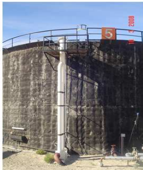
163) Sistema de incendio. Anillos rociadores. Cámara de espuma
