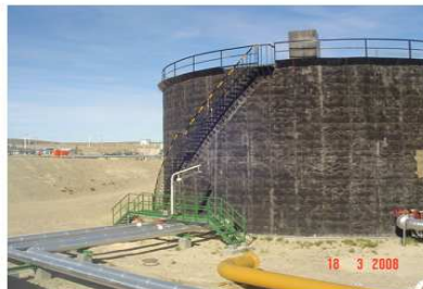
163) Sistema de incendio. Anillos rociadores. Cámara de espuma
