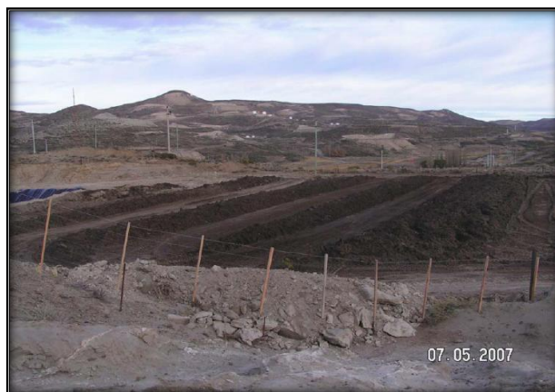
Foto 9: Vista de las biopilas en el repositorio.
