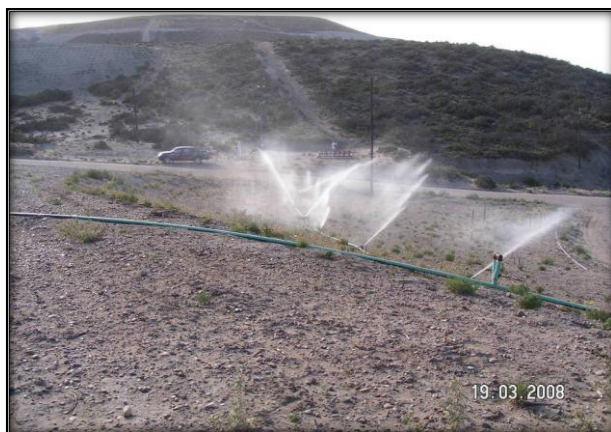
Foto 11: Sistema de riego por aspersión instalado.
