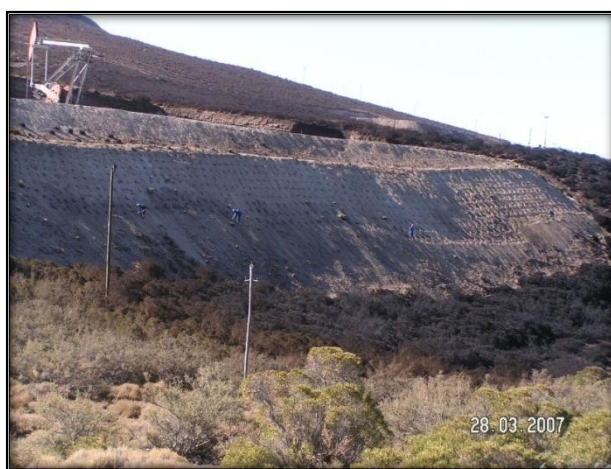
Foto 10: Tareas de conformación de microrrelieves y plantación de plantines.
