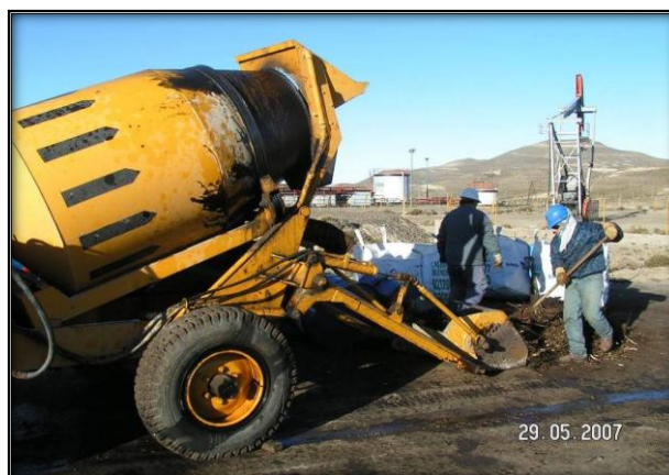
Foto 8: Hormigonera donde se realizó el lavado en caliente y con detergente biodegradable del material triturado con presencia de hidrocarburo.
