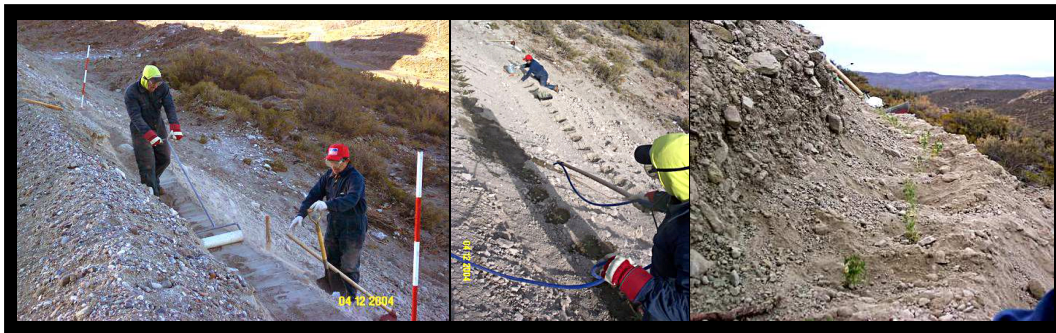
Foto 1: a) tareas de aterrazado b) nplantación v riego c) aspecto final
