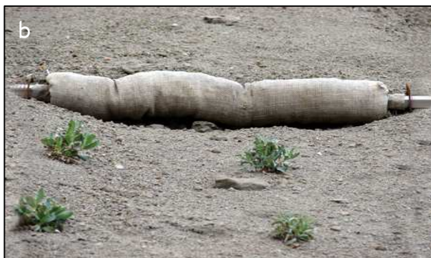
Foto 2: a) colocación de barreras para reducir los deslizamientos de material b) acción protectora sobre las plantas c) material retenido por las barreras
