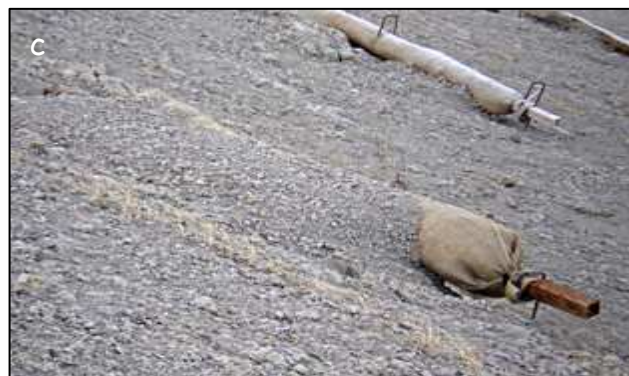
Foto 2: a) colocación de barreras para reducir los deslizamientos de material b) acción protectora sobre las plantas c) material retenido por las barreras
