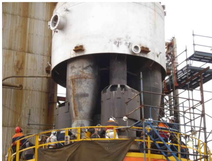
Fig. 26: Conjunto descendiendo dentro del Reactor
