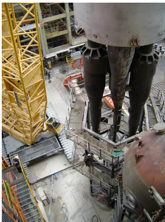
Fig. 24 : Elevación del conjunto desde la estructura soporte
