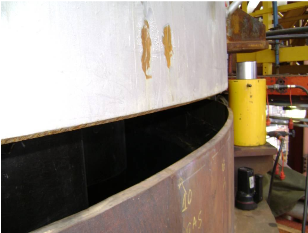
Fig. 29 : Posicionamiento final del cabezal mediante la utilización de gatos hidráulicos.
