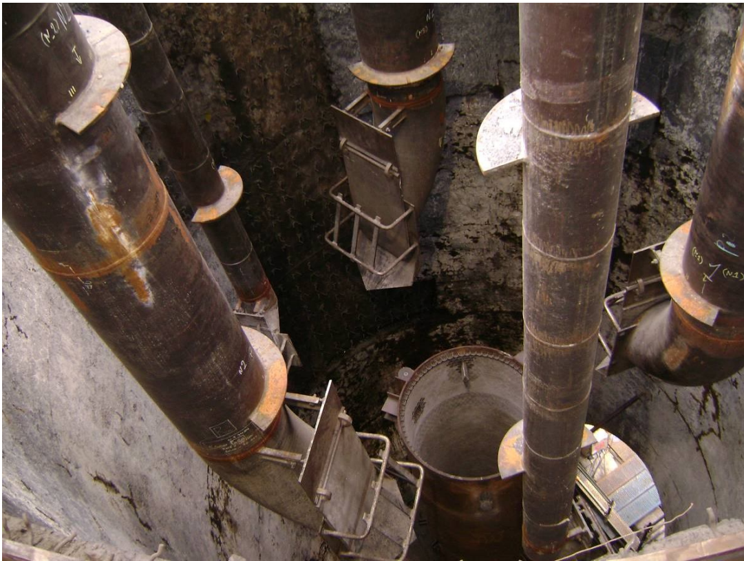
Fig. 28 : Descenso de los ciclones al interior del Reactor.
