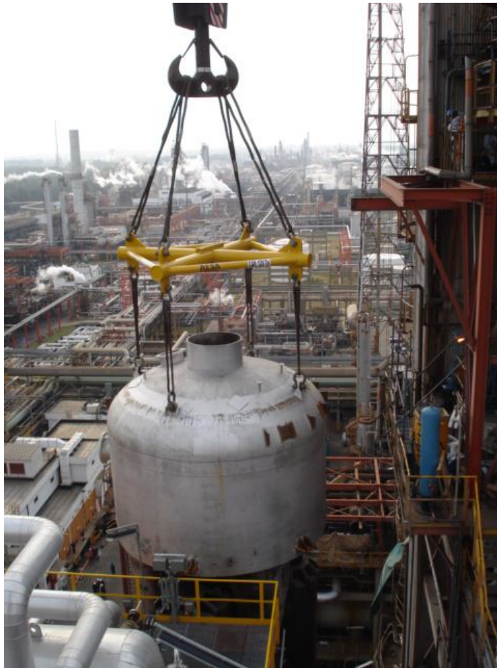
Fig. 25 : Se observa la percha de izaje, diseñada para tal fin y previamente ensayada
