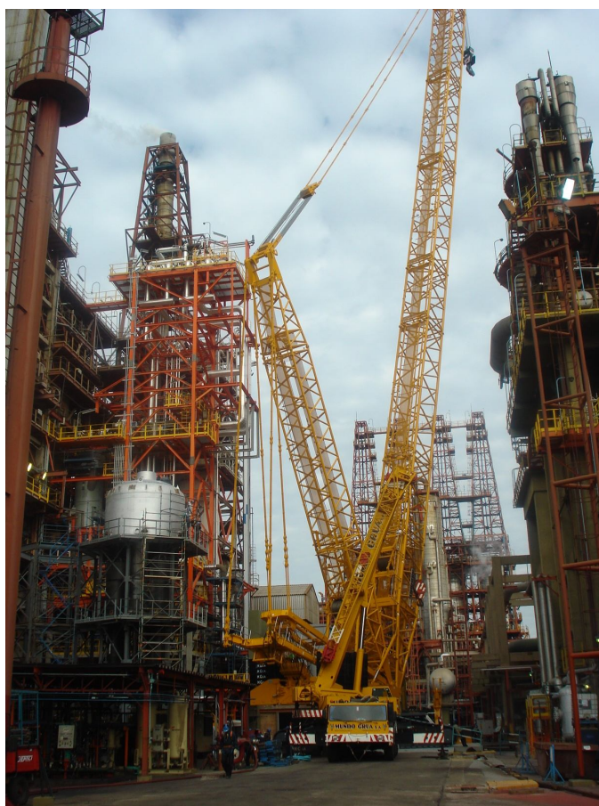
Fig. 23: Implantación de la grúa en el lugar de trabajo
