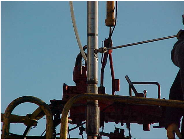
Instalación de la fuente radioactiva conservando las distancias
