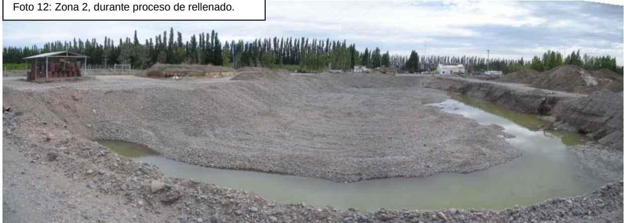
Foto 12: Zona 2, durante proceso de relleno.
