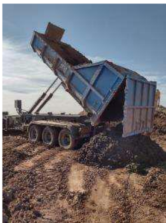
Fotografía 4 - Traslado de sólidos a sitio de acopio
