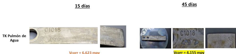
Figura 23 – Velocidad de corrosión observada a lo largo del piloto.
