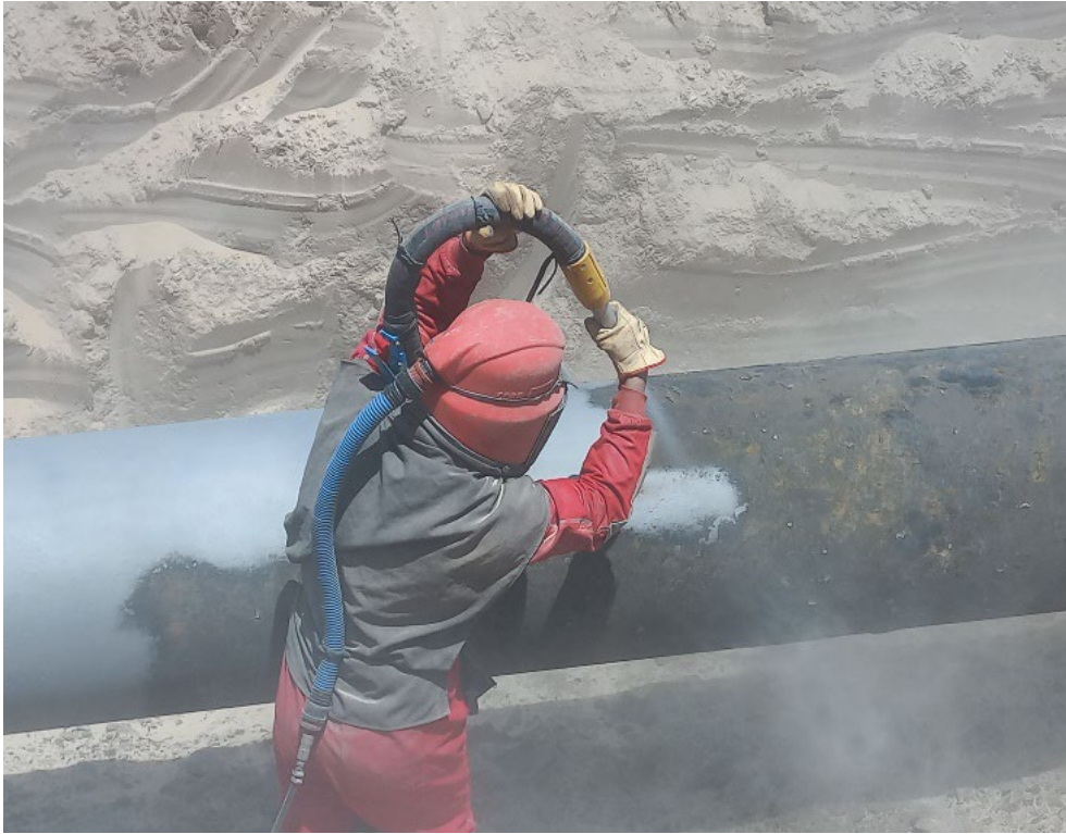
Figura 1: Proceso de limpieza por chorro abrasivo con arena.
