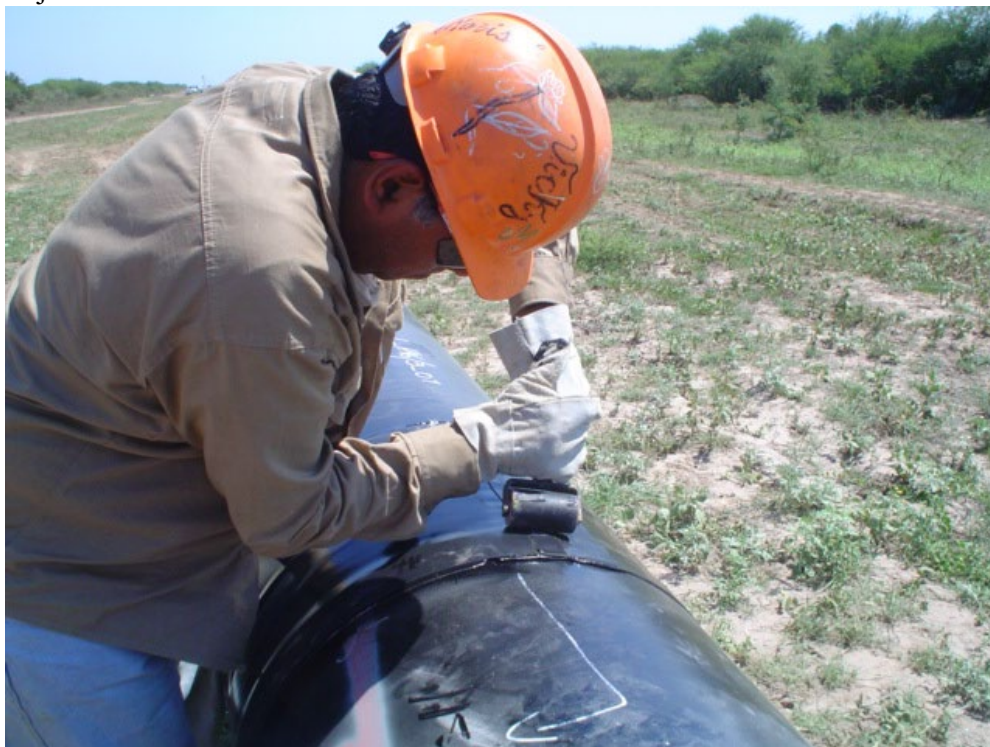
Figura 20: Eliminación de burbujas de aire y arrugas con rodillo.
