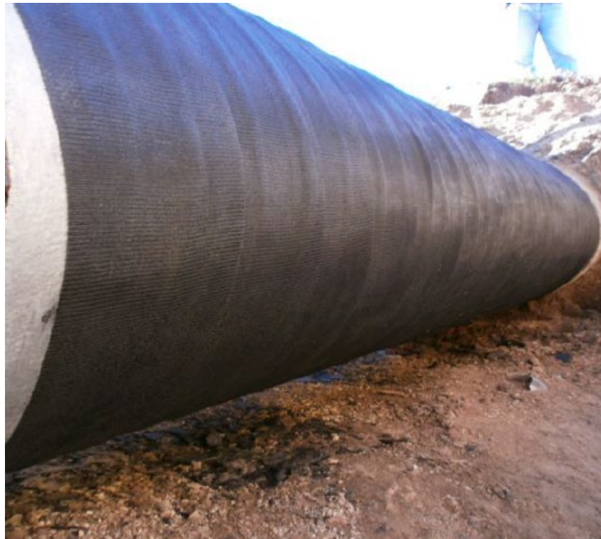
Figura 23: Aplicación de cinta externa.
