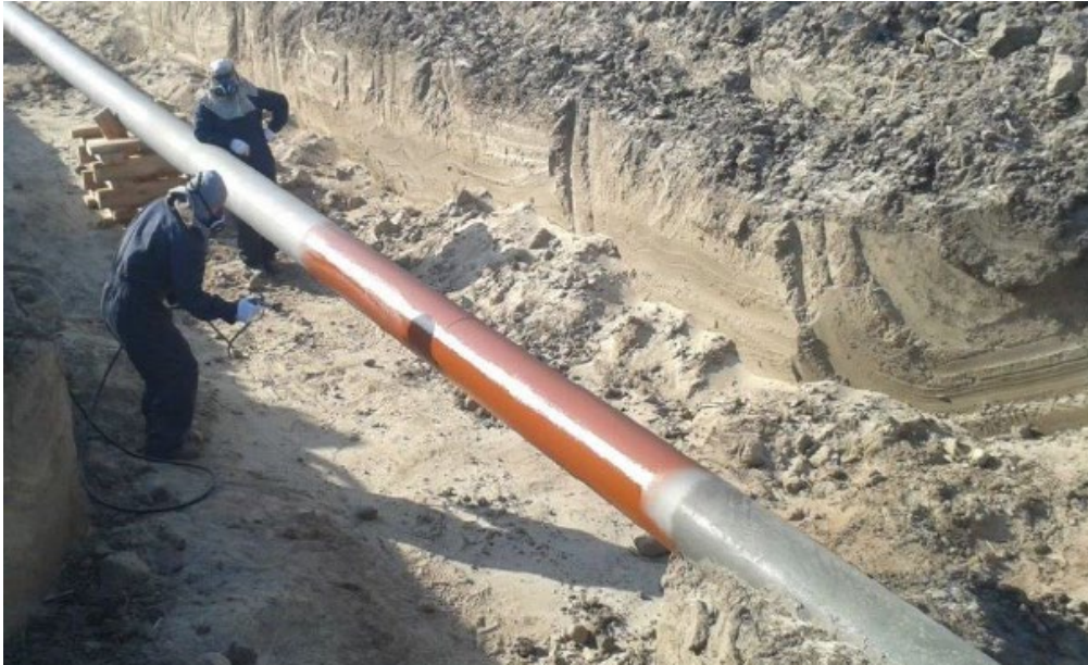
Figura 10: Aplicación de pintura epoxi líquida sin solventes sobre ducto en servicio.
