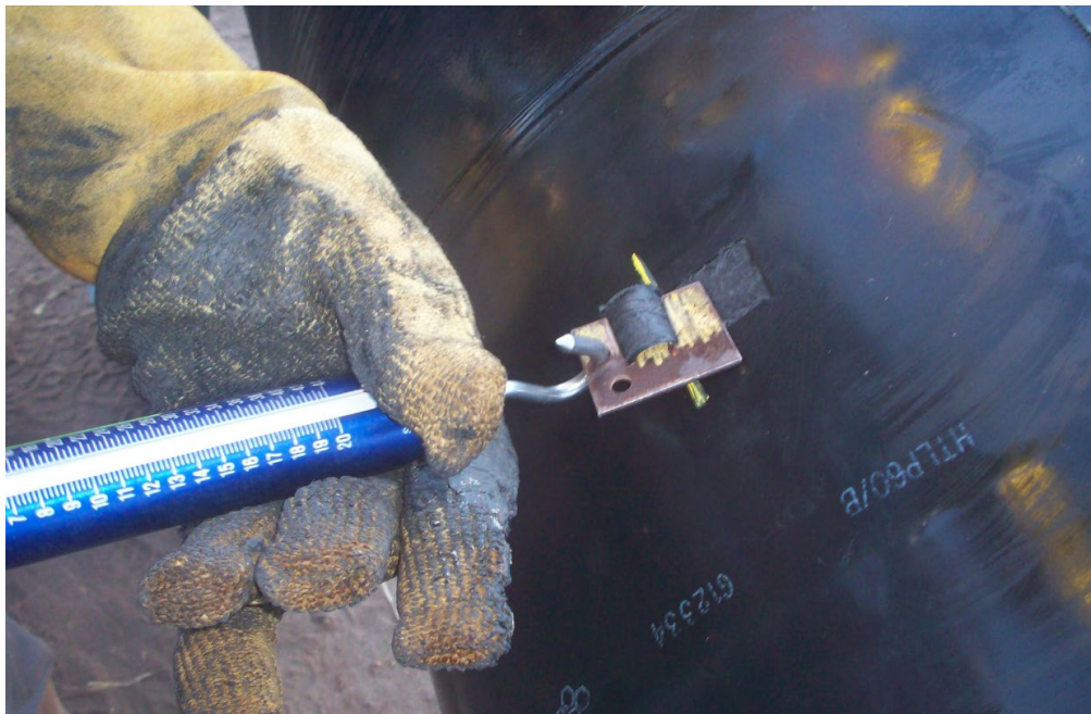
Figura 26: Ensayo de adherencia con dinamómetro.
