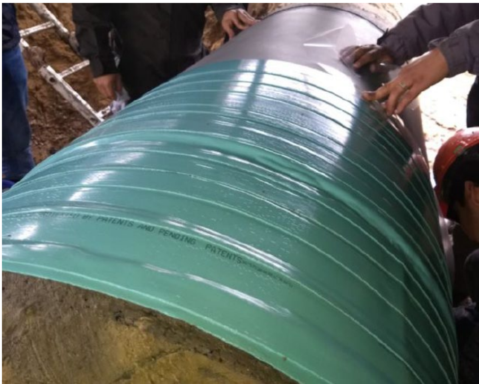
Figura 24: aplicación de cinta viscoelástica.
