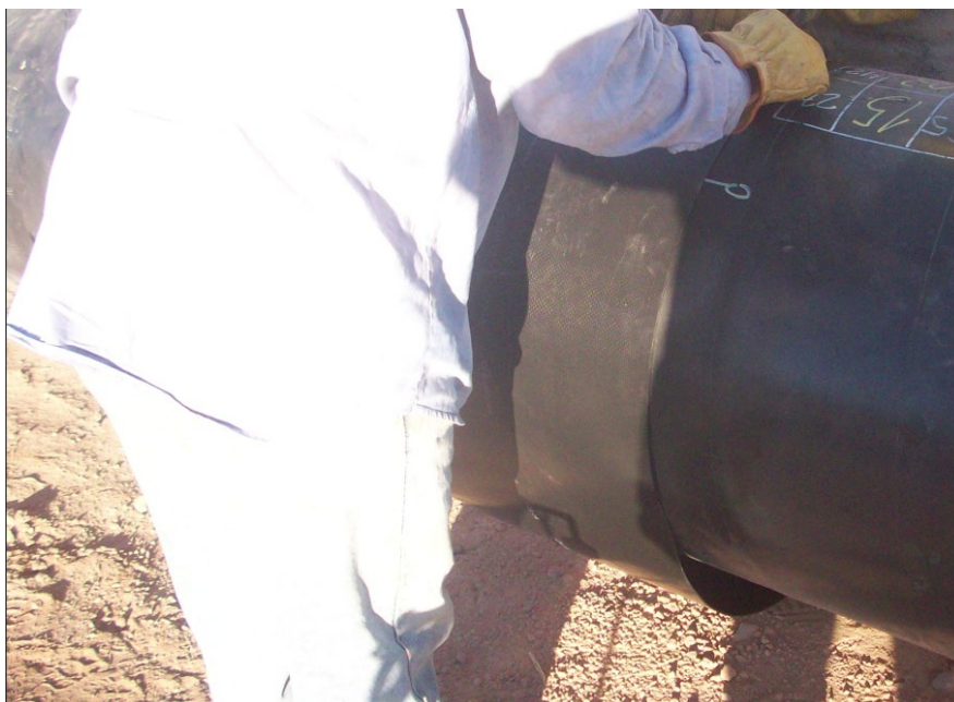
Figura 17: Presentación de la manta alrededor del ducto.
