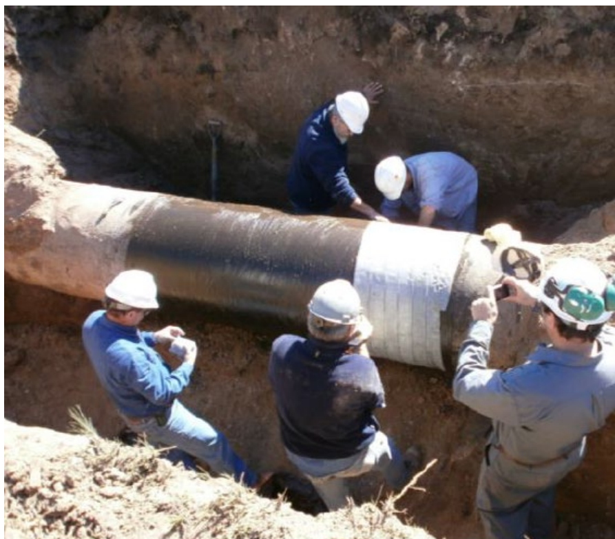
Figura 22: Aplicación de cinta embebida en cera.
