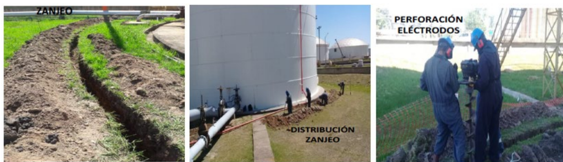
Fig. 3 - Instalación del sistema de Protección Catódica Distribuido.
