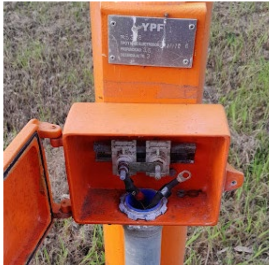
Fig. 7 - Mojón de interconexión anódica, empalme de dispersores.
