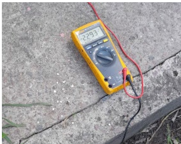
Fig. 5 -Toma de potencial en punto B con regulación al 50% de la corriente habitual.
