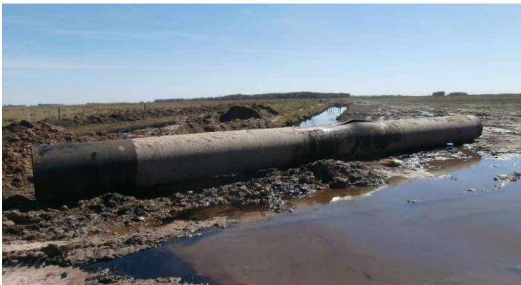
Fig. 6: Inspección Visual en el sitio de falla
