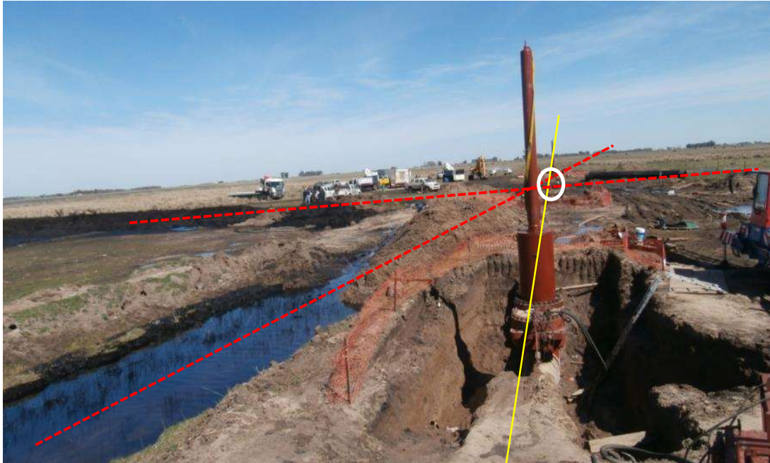
Fig. 9: Traza del gasoducto con relación a los canales del superficialario
