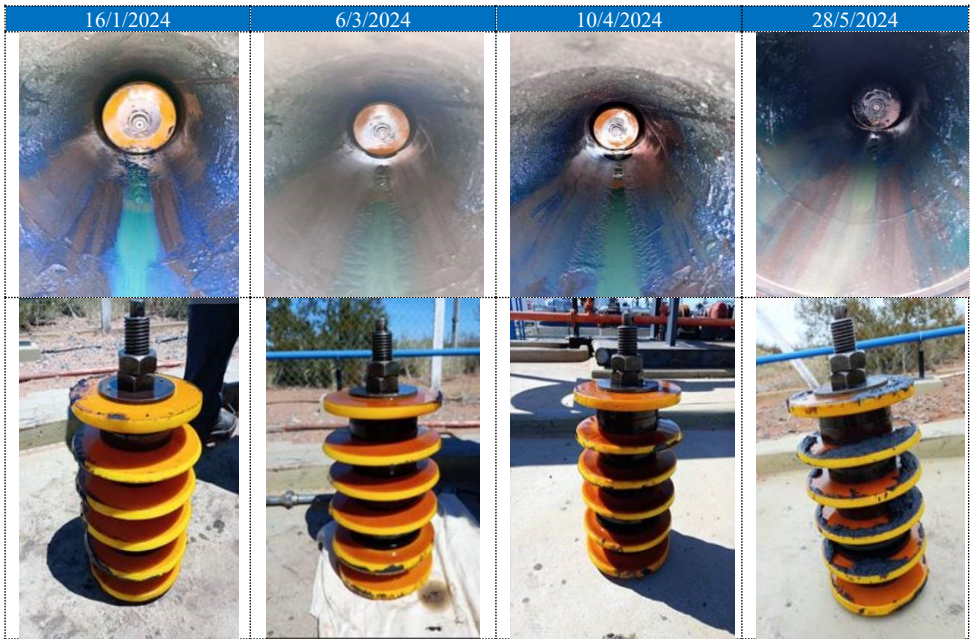
Figura 27 – Limpiezas periodicas en Tramo 2.
