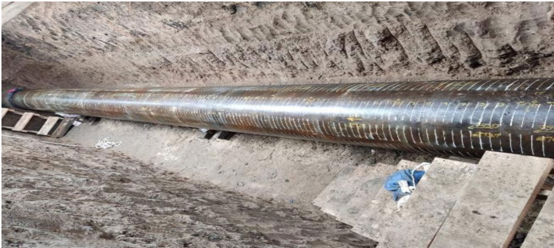
Figura 10: Pozo en pk 22,8. Caños con marcas para guía del palpador de ultrasonido (GTL, 2023).
