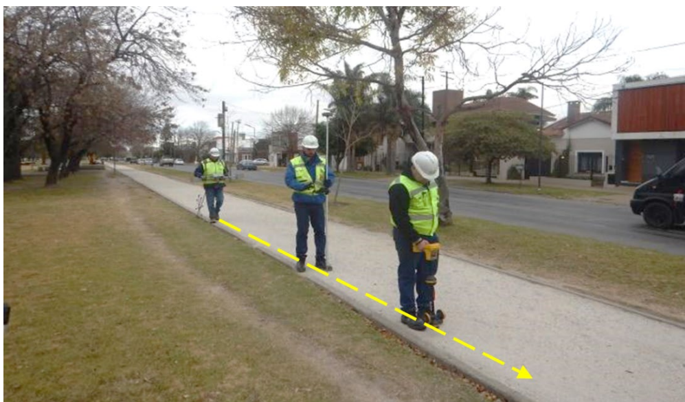
Figura 3: Relevamiento de MMM. De derecha a izquierda, operarios efectúan (1) ubicación del ramal y medición de tapada, (2) georreferenciación (GPS) y (3) medición de campo magnético. (IGP, 2022)
