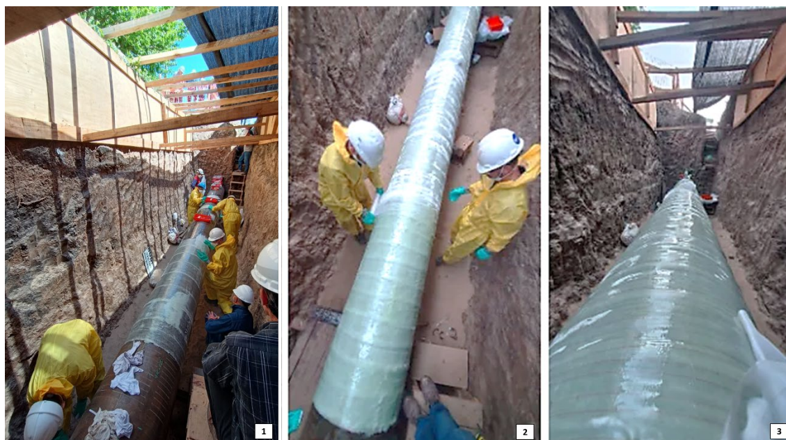
Figura 14: (1) Colocación de primera capa de refuerzo, (2) colocación de peel ply luego de la última capa de refuerzo y (3) retiro de peel ply y acabado final.
