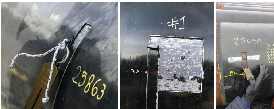
Figura 6a - 6b – 6c. Ensayo de adherencia del recubrimiento.
