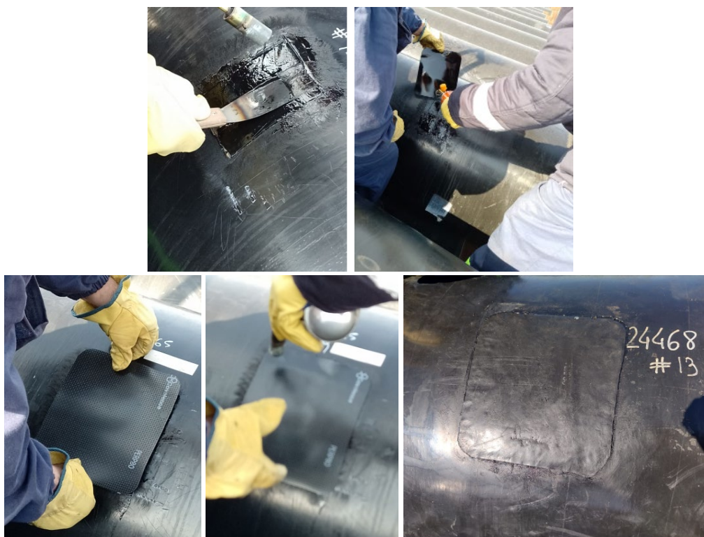
Figura 5a – 5b – 5c – 5d – 5e. Recomposición del recubrimiento.
