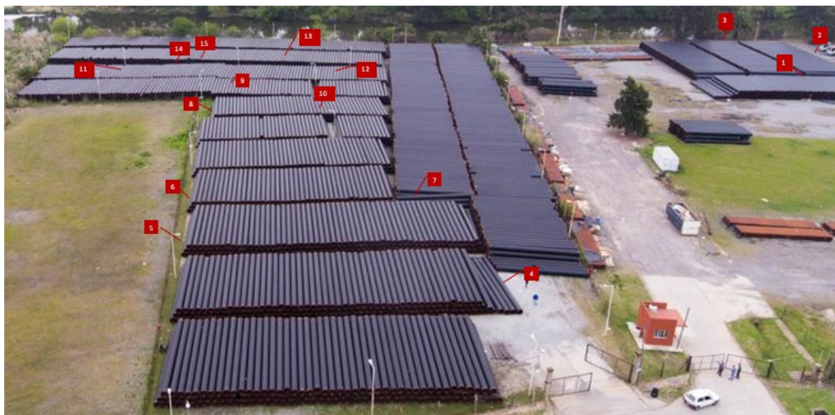
Figura 7. Ubicación de las zonas donde se realizó la extracción de muestras de recubrimiento.
