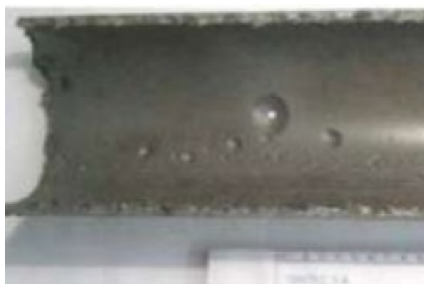
Figura 9. Corrosión por picadura (PAE, 2007)
